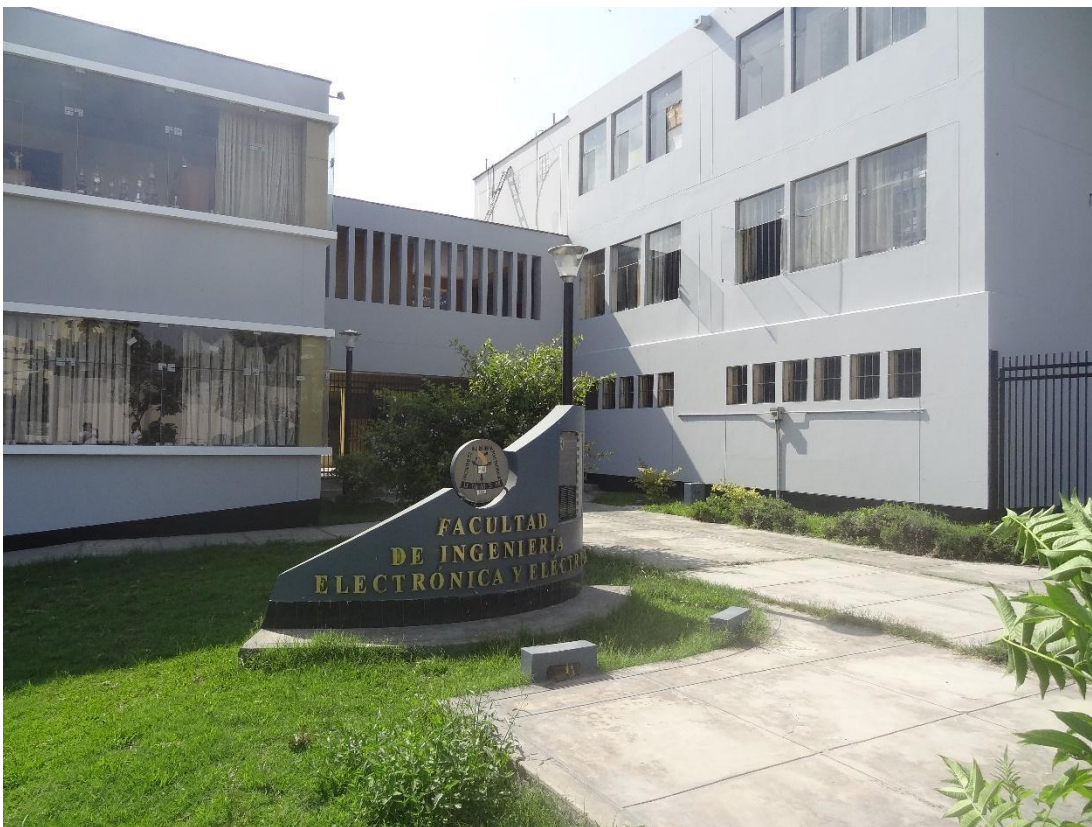
Figura 2. Ingreso al Pabellón B de la FIEE - UNMSM
