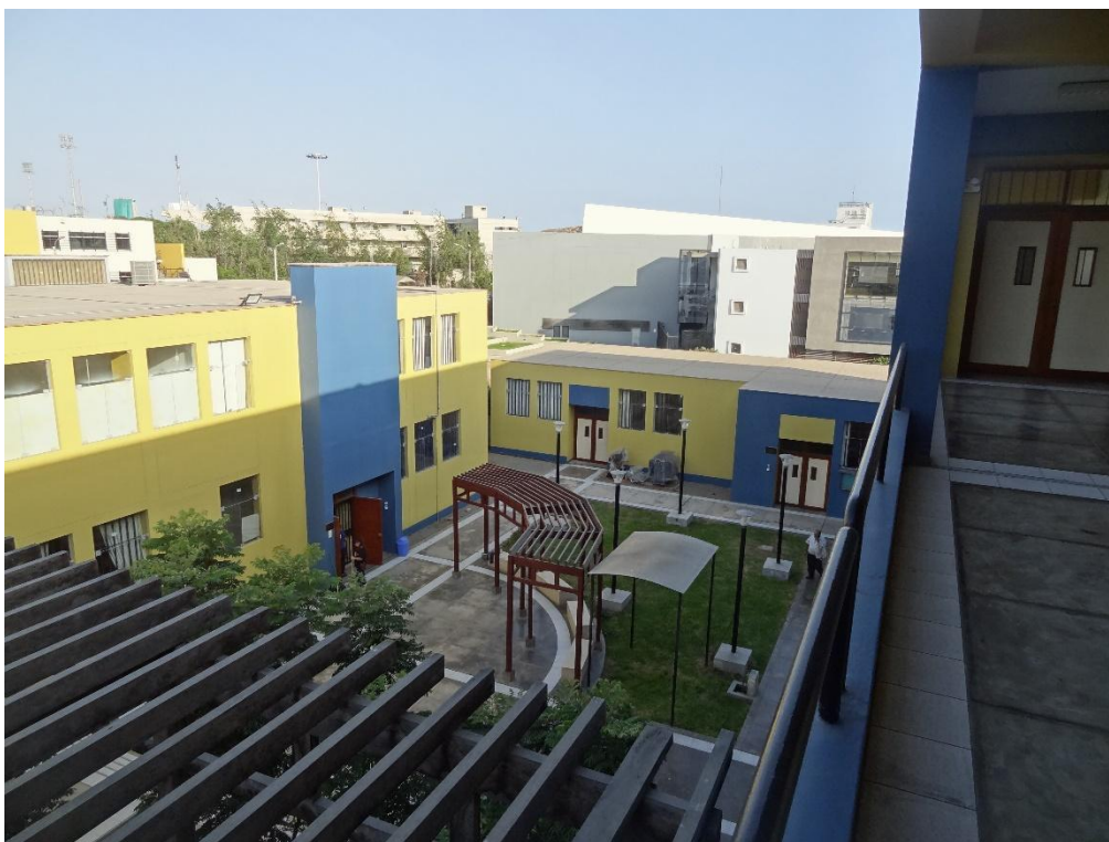
Figura 31. Vista de la explanada de la facultad
