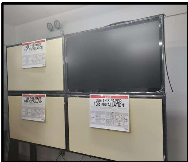
Figura 36 Instalación de monitores para el Video wall
