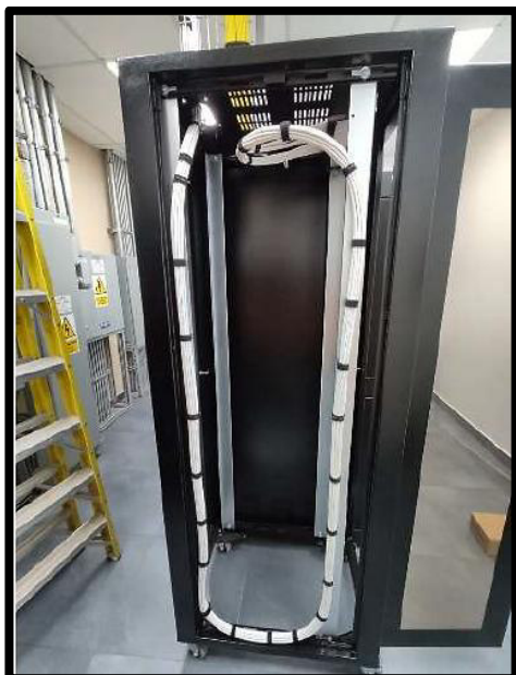
Figura 33 Instalación y ordenamiento de cables en el gabinete de datacenter Fuente. Datos obtenidos de MG Trading. Informe final CCTV MG Trading (2023).
