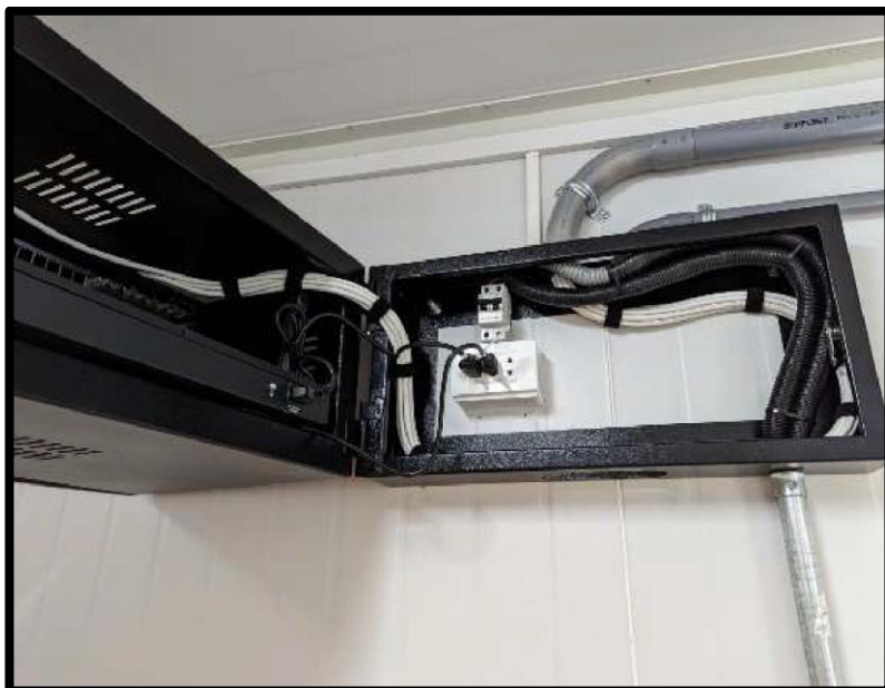
Figura 27 Instalación de gabinete de 8RU
