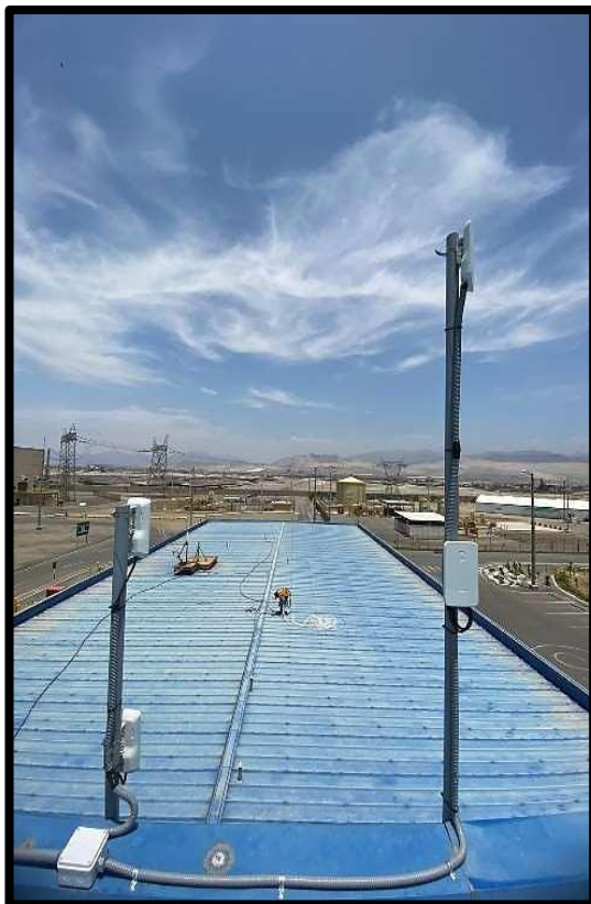
Figura 22 Instalación de radioenlaces en edificio administrativo
