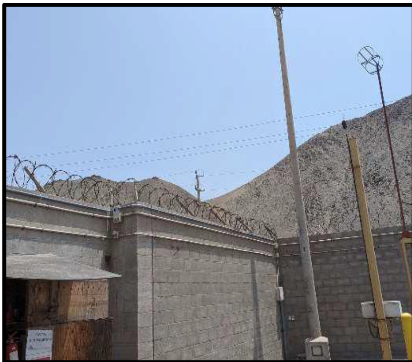
Figura 25 Instalación de tuberías Conduit rígido
