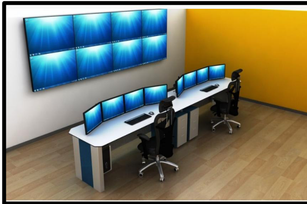
Figura 12 Centro de control con monitores de escritorio y video wall
