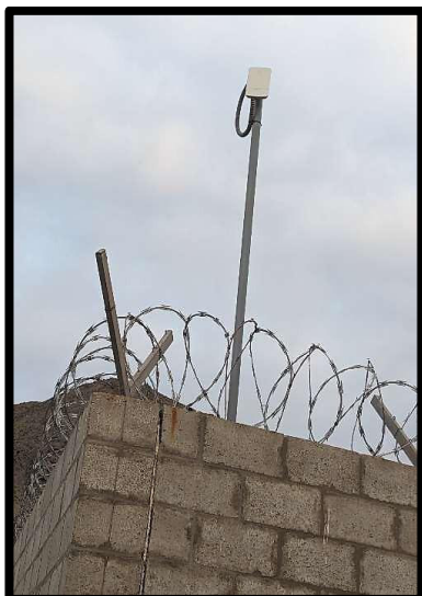
Figura 23 Instalación de radioenlace esclavo en Posta médica
