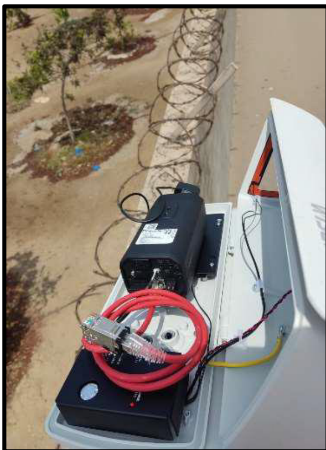
Figura 26 Instalación de cámara perimetral
