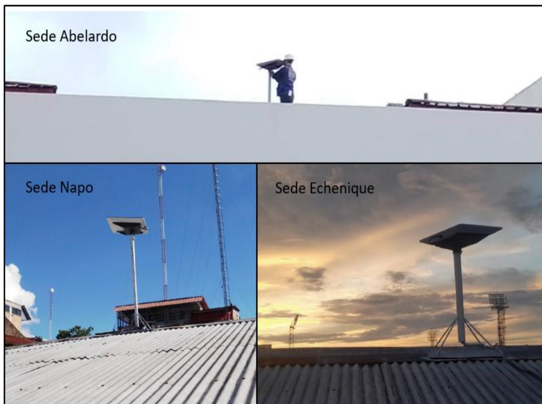
Figura 27 Instalación de la antena satelital. Fuente: Elaboración propia a partir de los datos proporcionados por Ingeniería Técnica.
