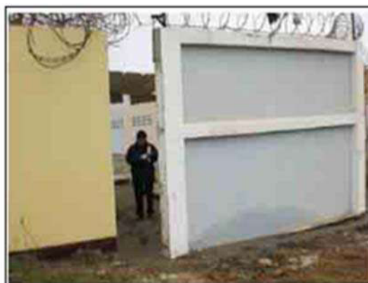
F-4.13.3 Desplazamiento horizontal del suelo ( lateral spread ). Los muros estaban unidos y se abrió una "puerta".
