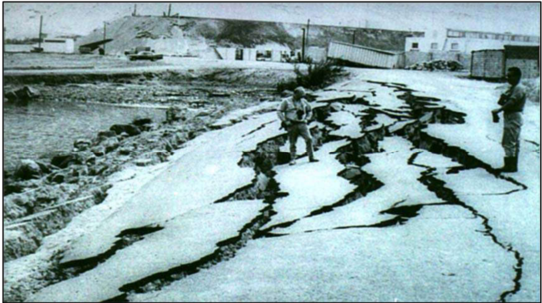
Figura 59. Licuación y desplazamiento lateral en Chimbote
