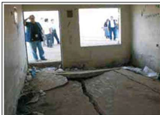
F-4.13.5 Los muros, por su propio peso y el de los techos, se hundieron más que los pisos que se "levantaron", quedando las viviendas totalmente inhabitables.
