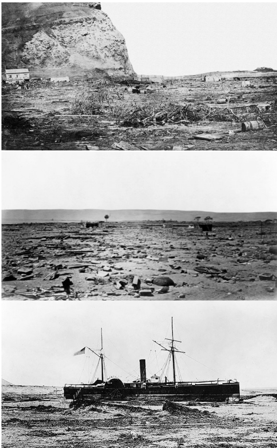
Figura 42. Fotos de Arica, luego del sismo y tsunami de 1868 Fuente. (Palacios, 2016)
