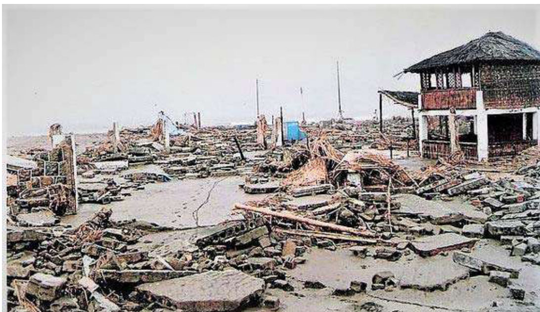
Figura 78. Daños causados por el tsunami en el balneario La Punta Fuente. (Hanco, 2018) https://diariocorreo.pe/edicion/arequipa/el-tsunami-que-destruyo-la-punta-en-camana-798641/?ref=dcr
