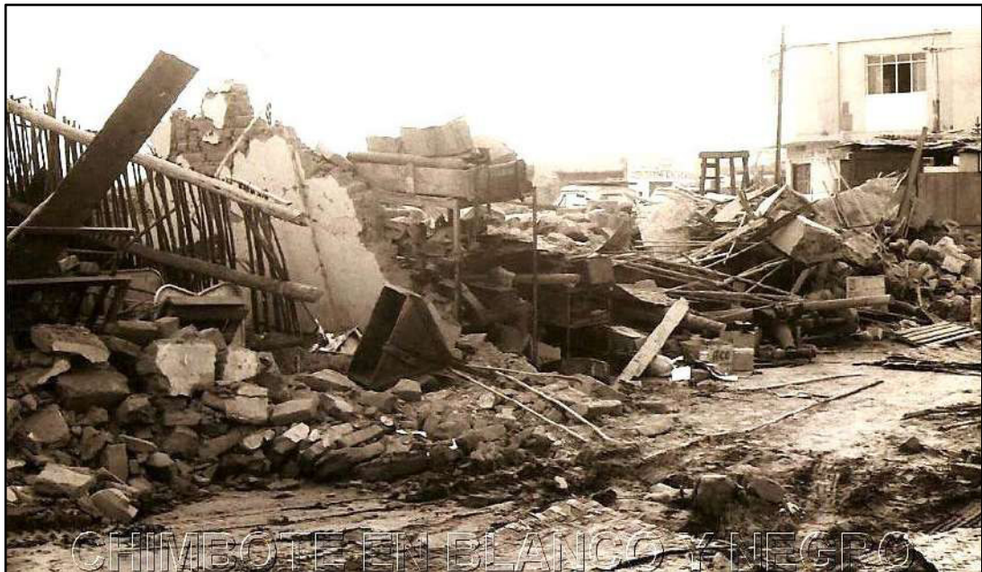
Figura 60. Severa destrucción en viviendas precarias en Chimbote
