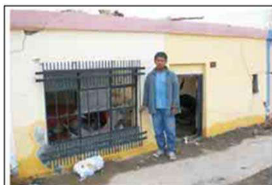
F-4.13.1 En Tambo de Mora hubo licuación generalizada de suelos. Numerosas casas se hundieron unos 80 cm. En Calle Nueva se hundió una fila de viviendas.
