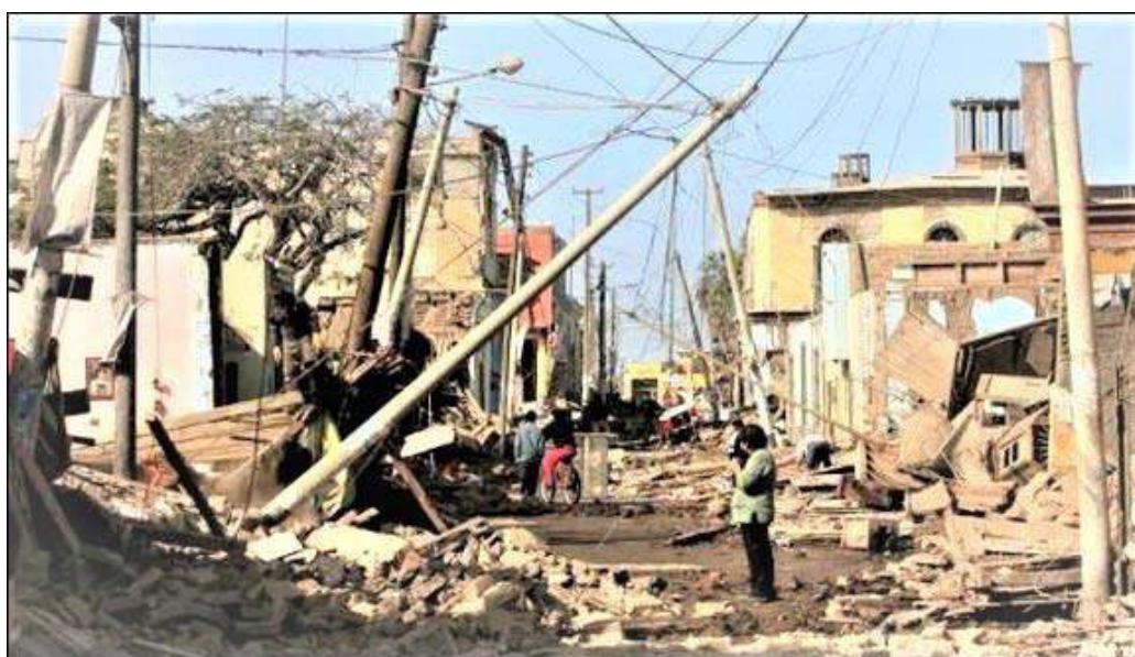
Figura 75. Calle céntrica de Moquegua, a días de ocurrido el sismo
