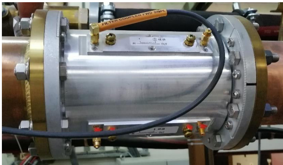
Figura 4: Acoplador direccional. Fuente: Elaboración propia.
