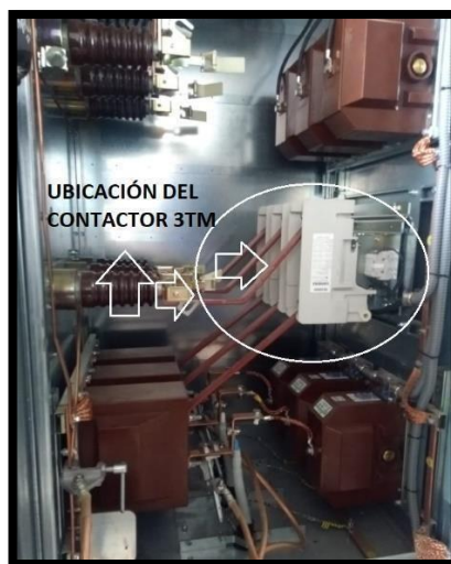
Figura 51: Ubicación Interior De La Celda. Fuente: Tomado por la página web celdas ingeteam
