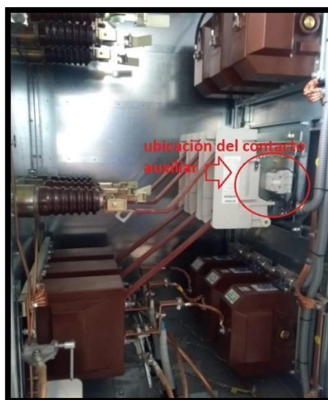
Figura 55: Ubicación Del Contacto Auxiliar. Fuente: Fotografía propia tomado en la central Wayra
