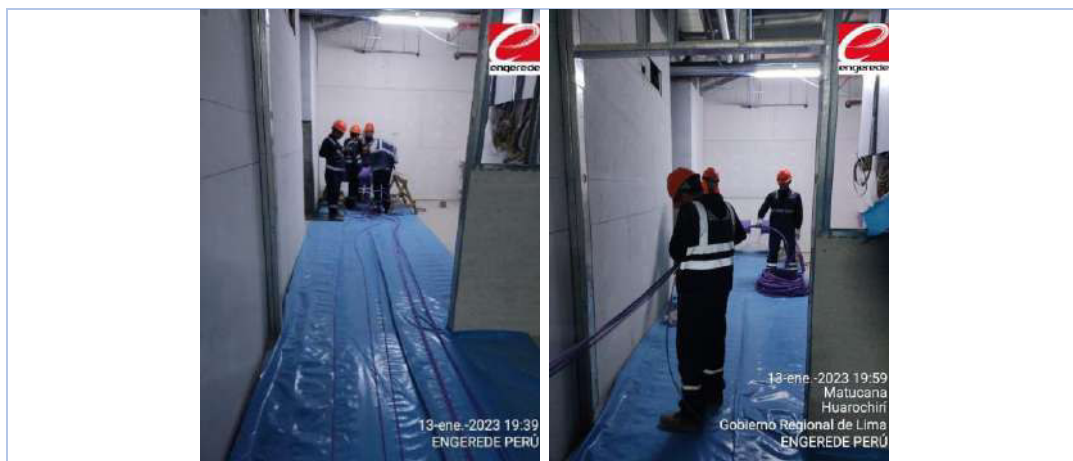
Figura 26. Proceso de metrado y corte. Fuente: Propia
