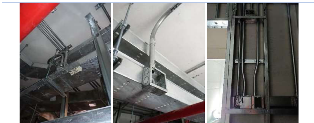
Figura 24. Instalación de canalización EMT. Fuente: Propia
