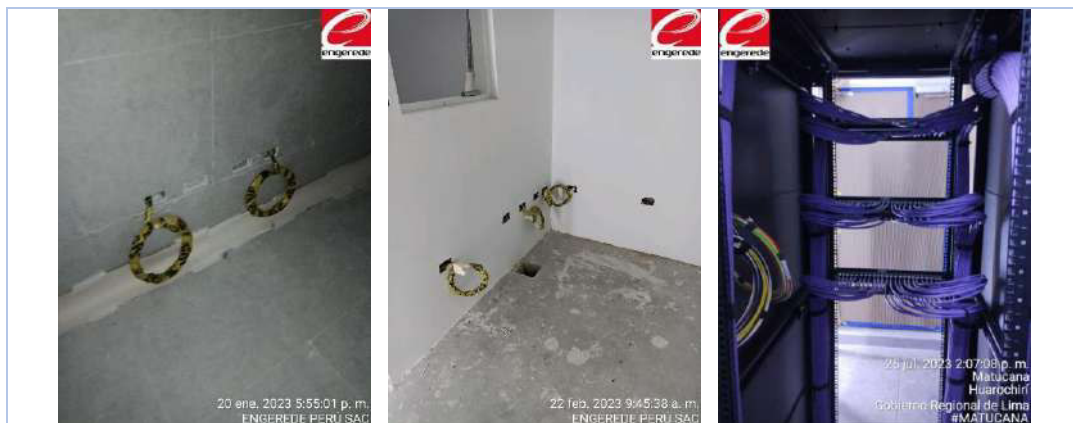
Figura 31. Reserva de cable en salidas de puntos de red. Fuente: Propia
