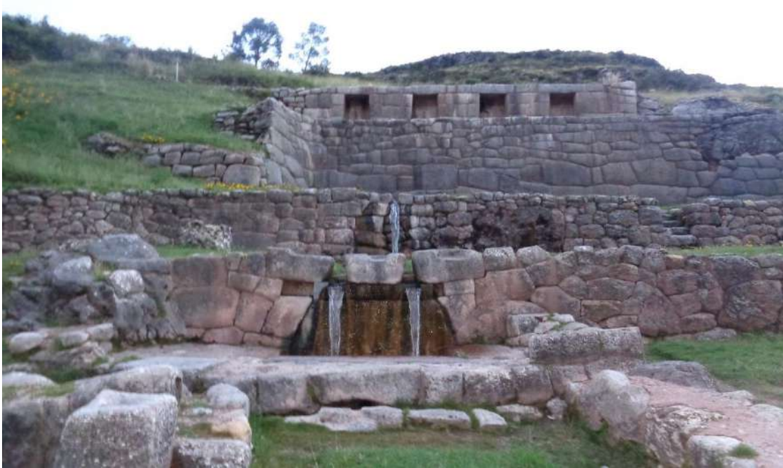
Figura I.6. Acueductos de Tambomachay, Cusco. Obra hidráulica sorprendente y de gran perfección, construido para la circulación del flujo de fluido en dos canales de salida. Se observó que el transporte molecular, para el flujo de cierta cantidad física transportada, se encuentra en estado de equilibrio con su alrededor.
