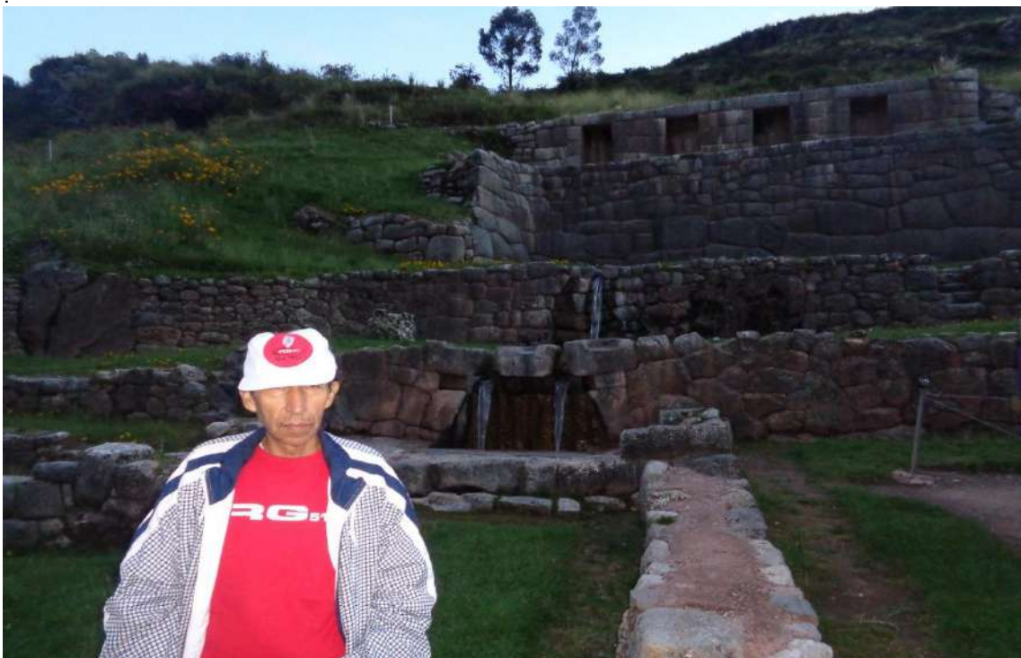
Figura I.7. Acueductos de Tambomachay, Cusco. Obra hidráulica sorprendente y de gran perfección, construido para la circulación del flujo de fluido en dos canales de salida. Se observó que el transporte molecular, para el flujo de cierta cantidad física transportada, se encuentra en estado de equilibrio con su alrededor.
