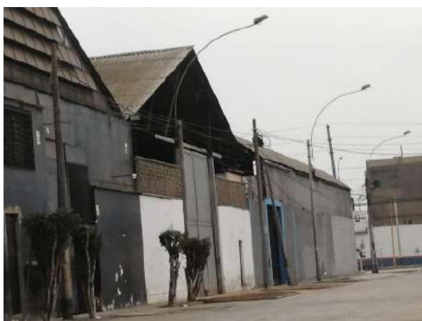
Techo de Fibrocemento 3
