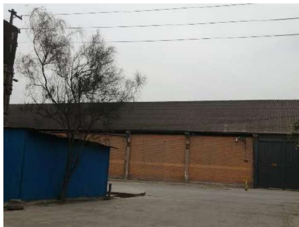
Techo de Fibrocemento 4
