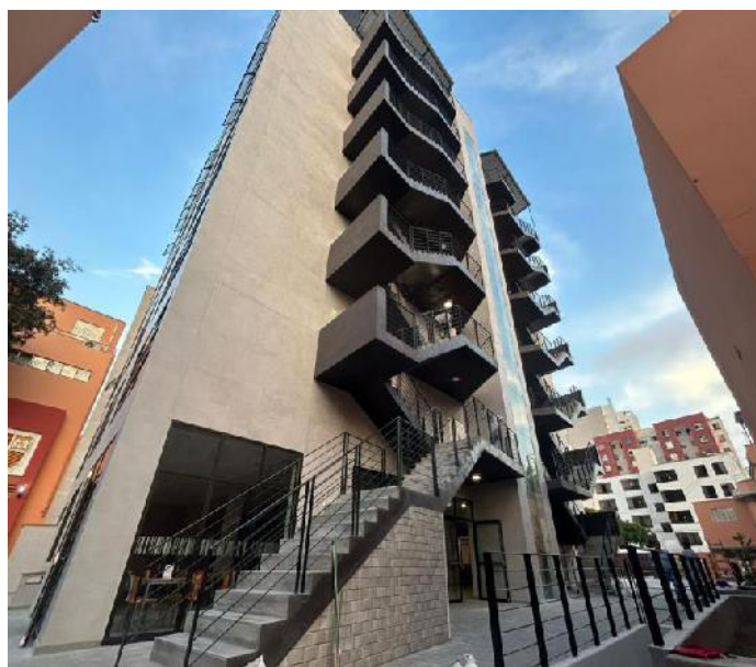
Figura 8. Fachada de Edificio Vicente Santuc
