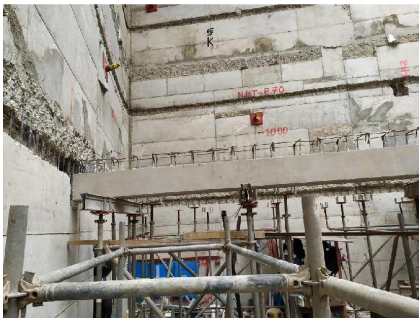
Figura 5. Previgas en obra Fuente: Información brindada por Betondecken
