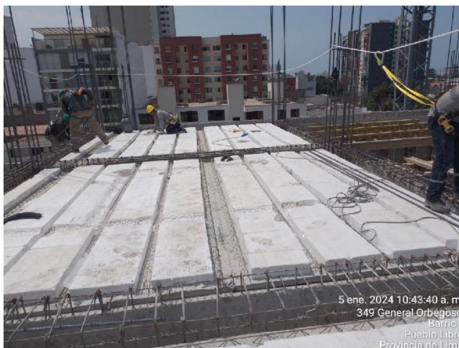
Figura 1. Prelosas Betondecken en obra Fuente: Propia. Tomada en obra
