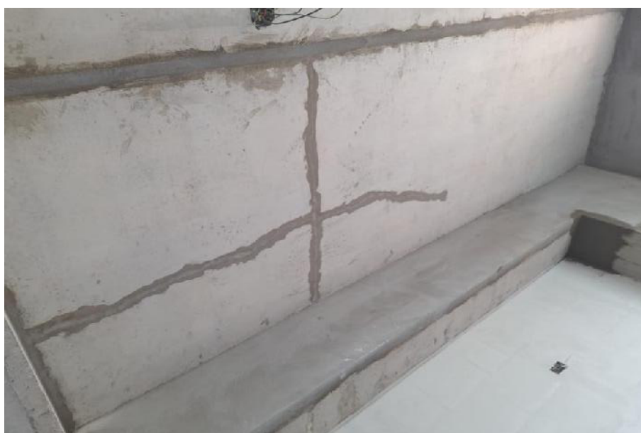
Figura 65. Reparación de fisuras encontradas Fuente: Panel fotográfico - UARM
