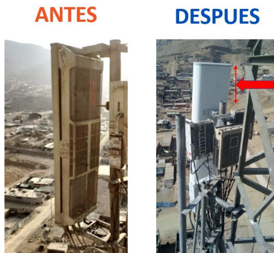
Figura 48 - Franja superior en mástil existente. Fuente: Trabajos en Franja
