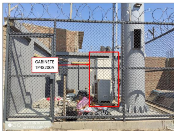
Figura 14 - Delivery de equipos. Fuente: Foto Tomada
