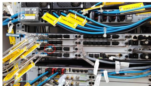
Figura 19 – Tarjeta UBBPe4 insertada. Fuente: Foto Tomada
