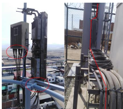
Figura 16 - Jumpers existentes. Fuente: Fotos Tomadas
