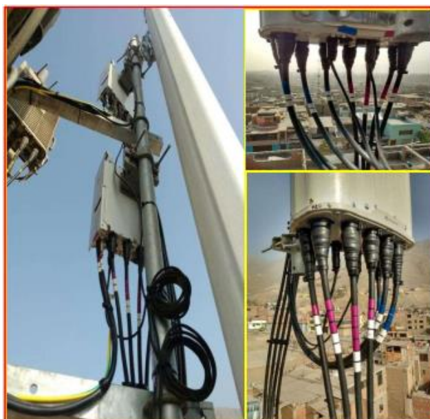
Figura 40 - Instalación de Jumpers. Fuente: Estándar “LTE FDD 2.6 GHz Ranco”
