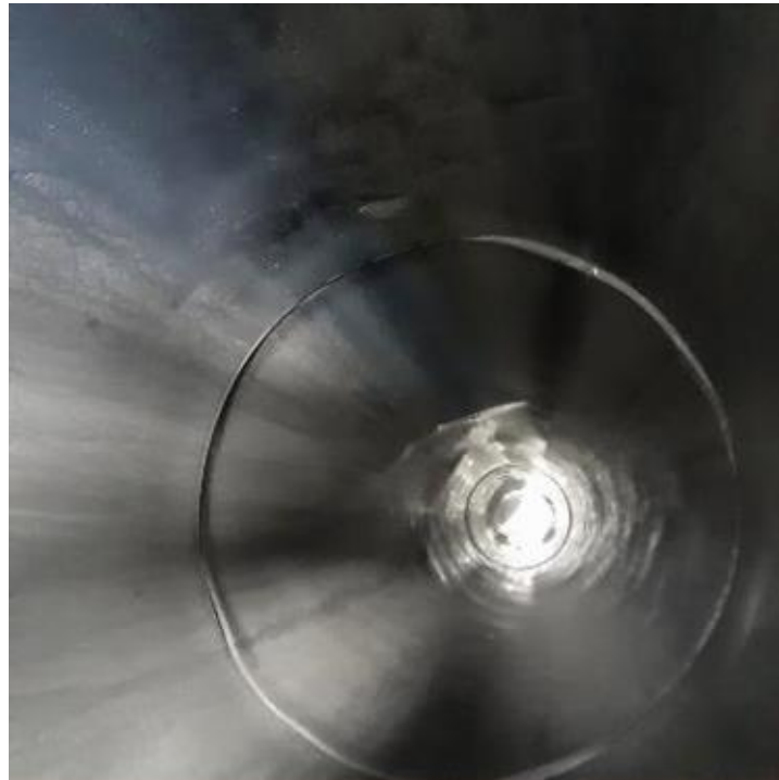
Foto 4. Interior Hidrociclón D20.
