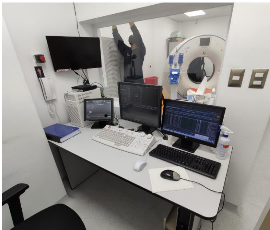
Figura 12. Instalación del sistema CYMREM. Fuente: propia
