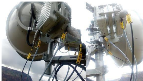
Figura 127. Vulcanizado y etiquetados de las ODUs instaladas en la estación Marias. Fuente: Elaboración Propia
