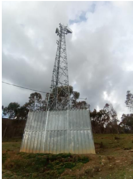
Figura 122. Vista panorámica de la estación Marias. Fuente: Elaboración Propia
