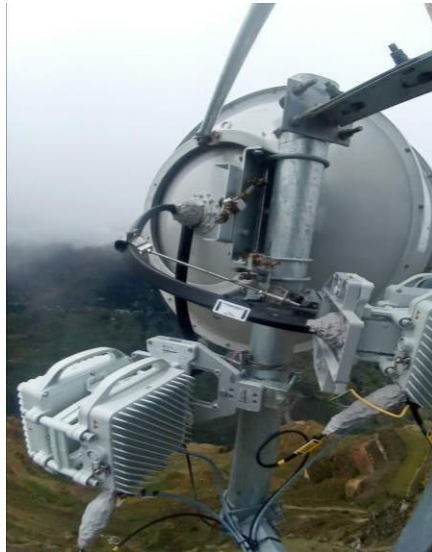
Figura 138. Vista del mástil de la estación Llata. Fuente: Elaboración Propia
