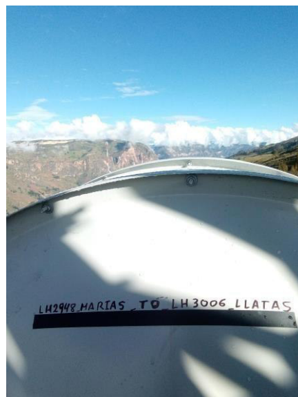
Figura 125. LOS y etiquetado del enlace microonda en la estación Marias. Fuente: Elaboración Propia
