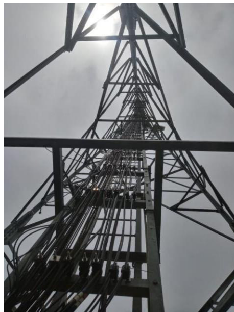
Figura 129. Recorrido vertical de los cableados outdoor en la estación Marias. Fuente: Elaboración Propia
