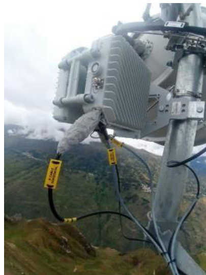
Figura 141. Vulcanizado y etiquetado de las ODUs en la estación Llata. Fuente: Elaboración Propia
