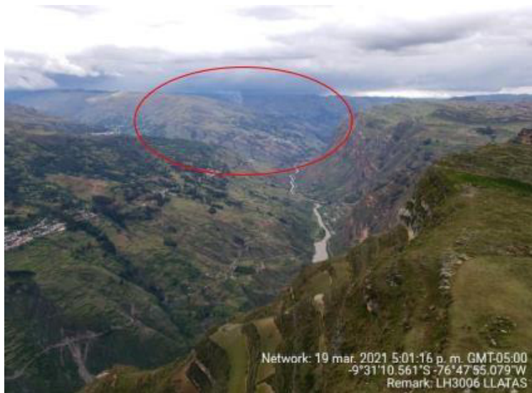
Figura 24. Vista con Zoom Normal de la estación Marias desde la estación Llata. Fuente: Elaboración Propia
