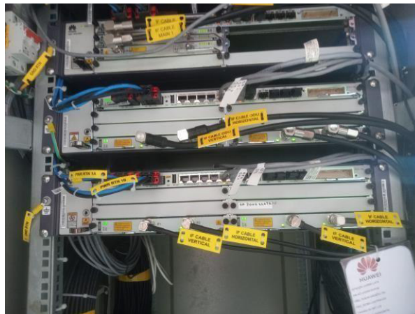
Figura 147. Vista frontal de la IDU en la estación Llata. Fuente: Elaboración Propia
