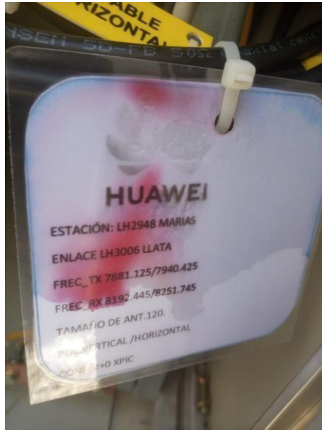
Figura 134. Etiquetado de la IDU en la estación Marias. Fuente: Elaboración Propia
