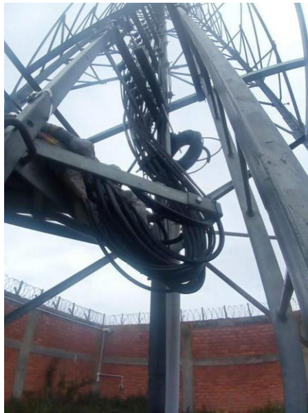
Figura 143. Recorrido Vertical de los cables outdoor en la estación Llata. Fuente: Elaboración Propia
