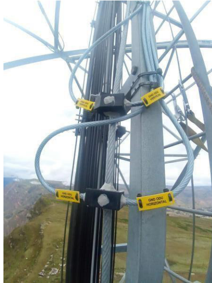
Figura 142. Vulcanizado y etiquetado de las ODUs en la estación Llata. Fuente: Elaboración Propia
