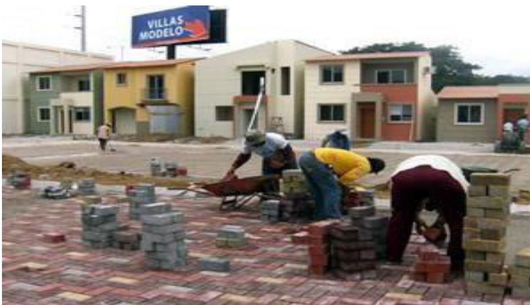
Km. 12 Vía Samborondón (Urbanización Sambo City)
