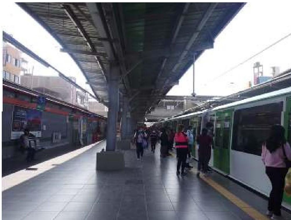
Ilustración 8. Estación del Metro María Auxiliadora, en Villa María del Triunfo, que es otro punto de confluencia de los quechuahablantes que residen en este distrito de la zona sur de Lima.
