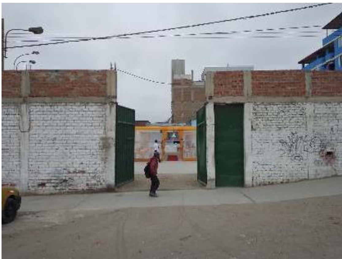
Ilustración 3. Aquí se puede apreciar la fachada del local San Antonio de Cachi, ubicado en la Avenida Primero de Mayo, Villa El Salvador, a una cuadra del Mercado Unicachi.
