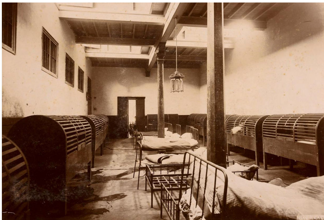
Figura N° 35. Habitación de cujas o jaulas para agitados. Fuente: Garreaud (1900).
