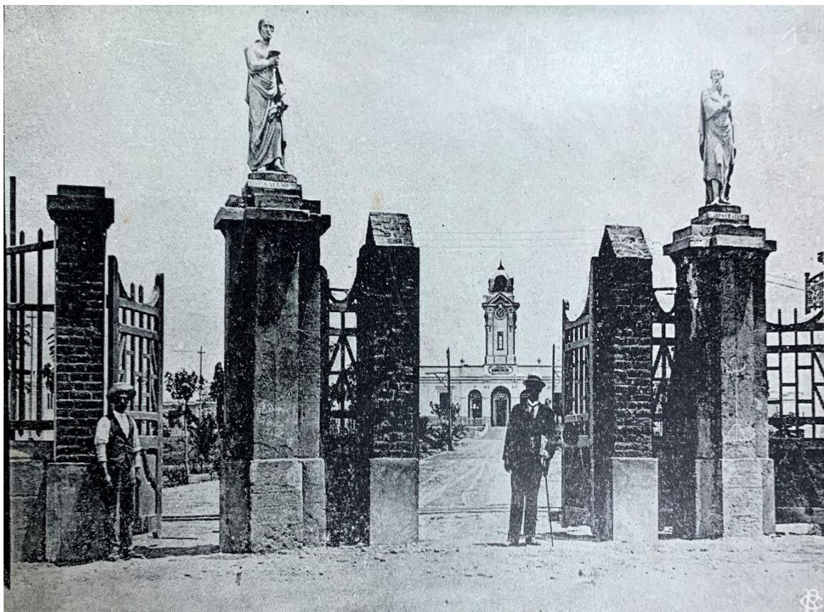
Figura N° 41. Entrada principal del Asilo Colonia de la Magdalena en 1918, con las esculturas en mármol de Hipócrates y Galeno, originalmente ubicadas en el Hospicio de Insanos. Fuente: Hospital Nacional de Alienados (1918).
