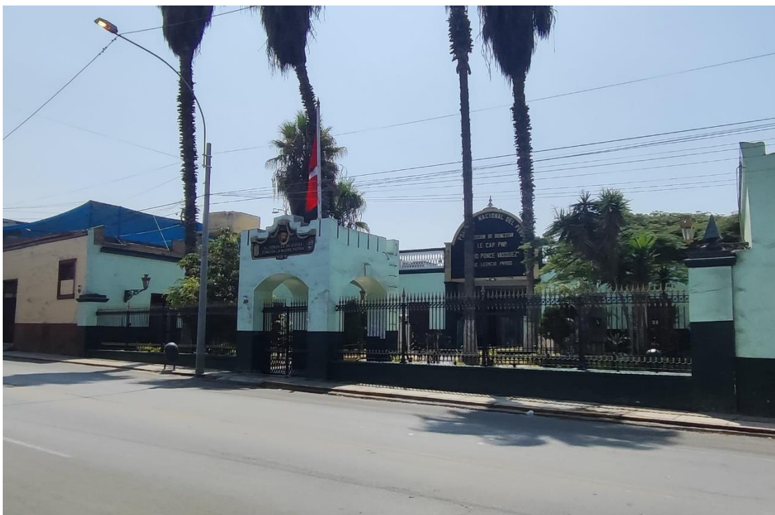
Figura N° 18. Fachada del I. E. P. N. P. Alipio Ponce Vásquez (av. Sebastián Lorente 769, Barrios Altos, Lima), ubicado en el antiguo Hospicio de Insanos. Fuente: Fotografía del autor, 6 de abril de 2025.
