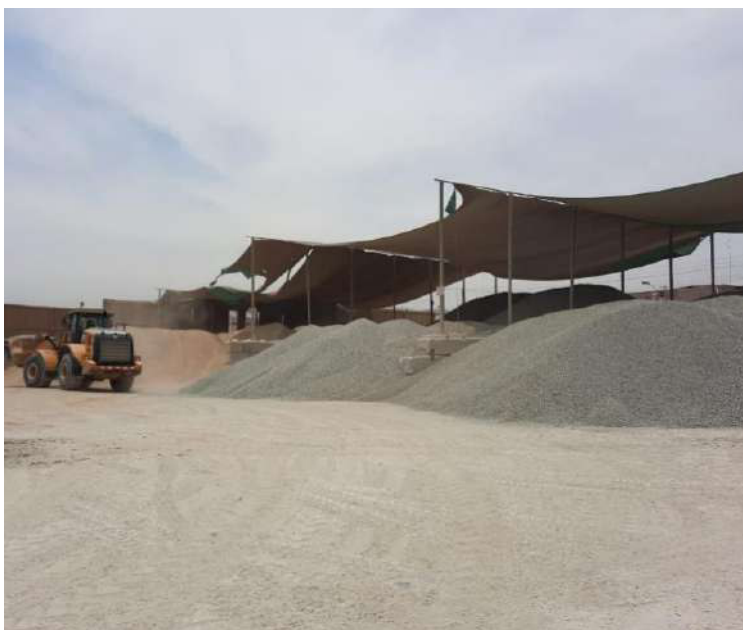
Figura 25. Almacenamiento de agregados en Mixercon - Planta villa 2
