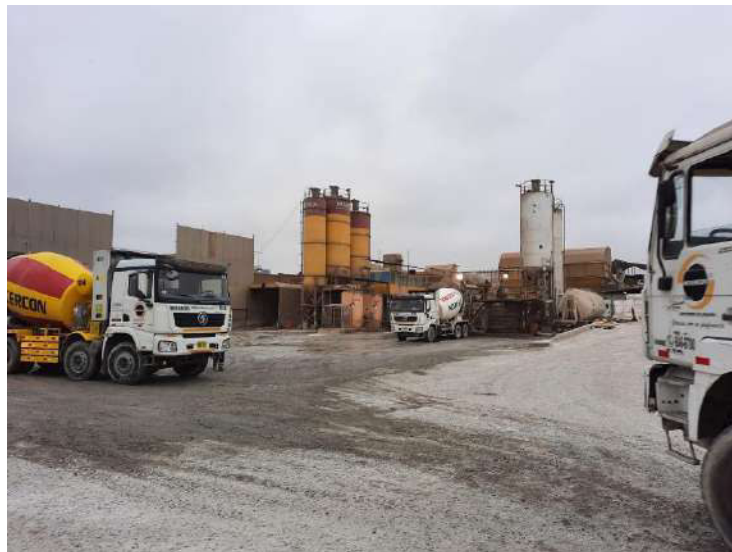
Figura 24. Producción de concreto en Mixercon-planta villa 2
