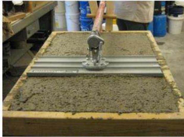
Figura 21. Acabado de superficie con Bull Float
