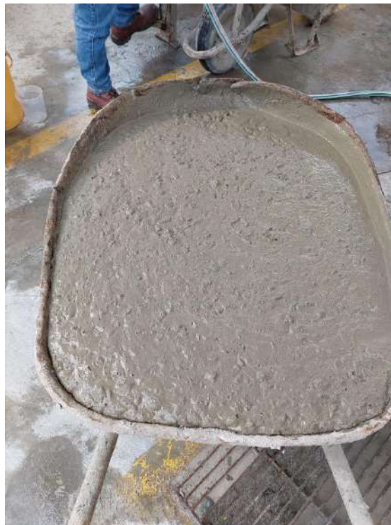
Figura H-10. Mezcla de concreto con SCRA, Sika Control NS.
