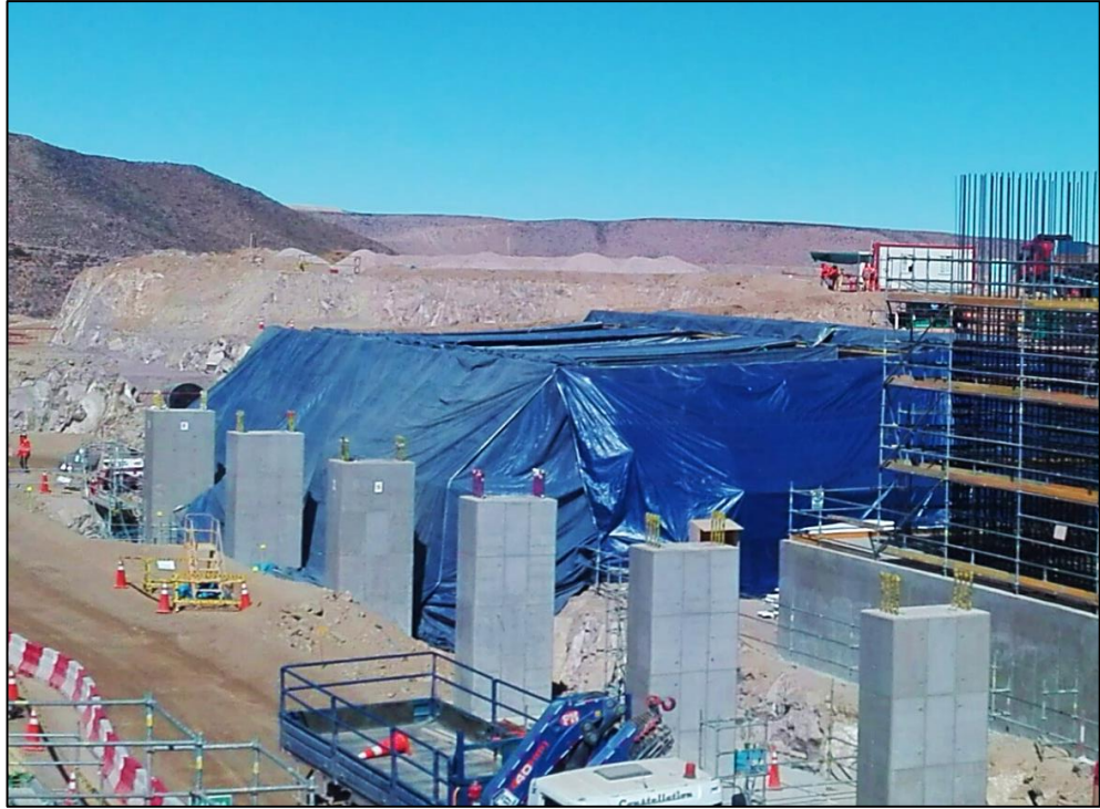
Figura 26. Fotografía de microclima ejecutado en campo para Cimentación de Molino de Bolas 01.
