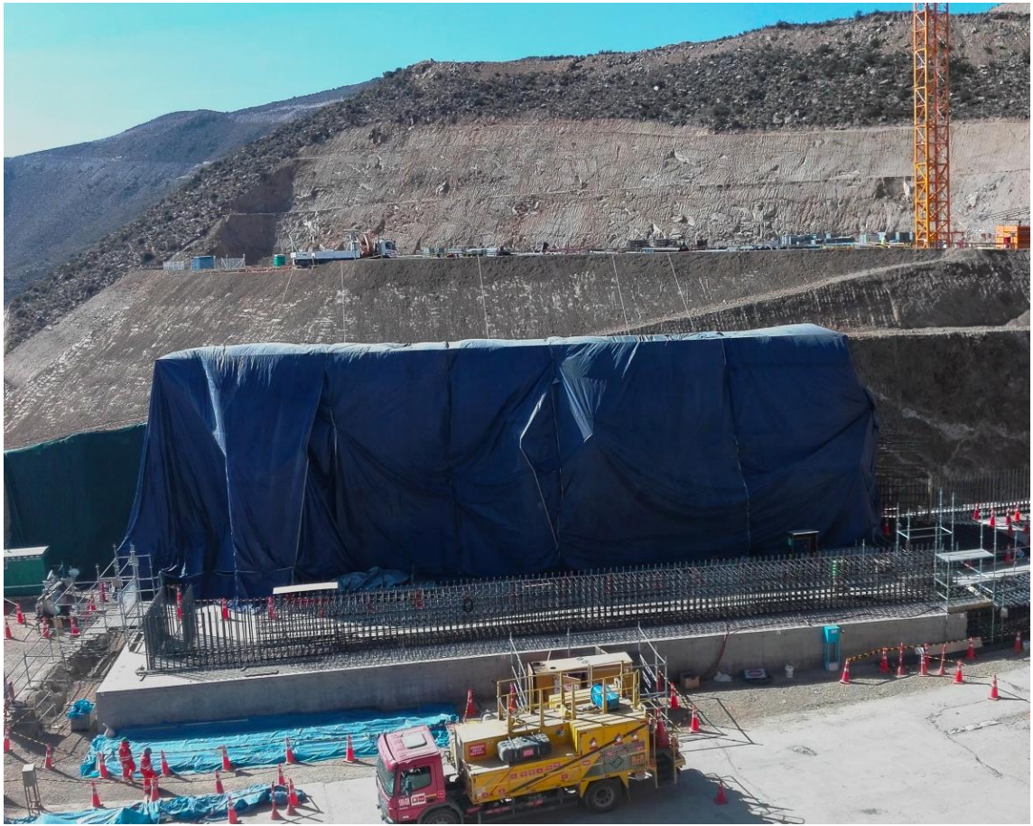
Figura 53. Fotografía de microclima ejecutado en campo para el Muro del Túnel de Recuperación (Etapa 01)
