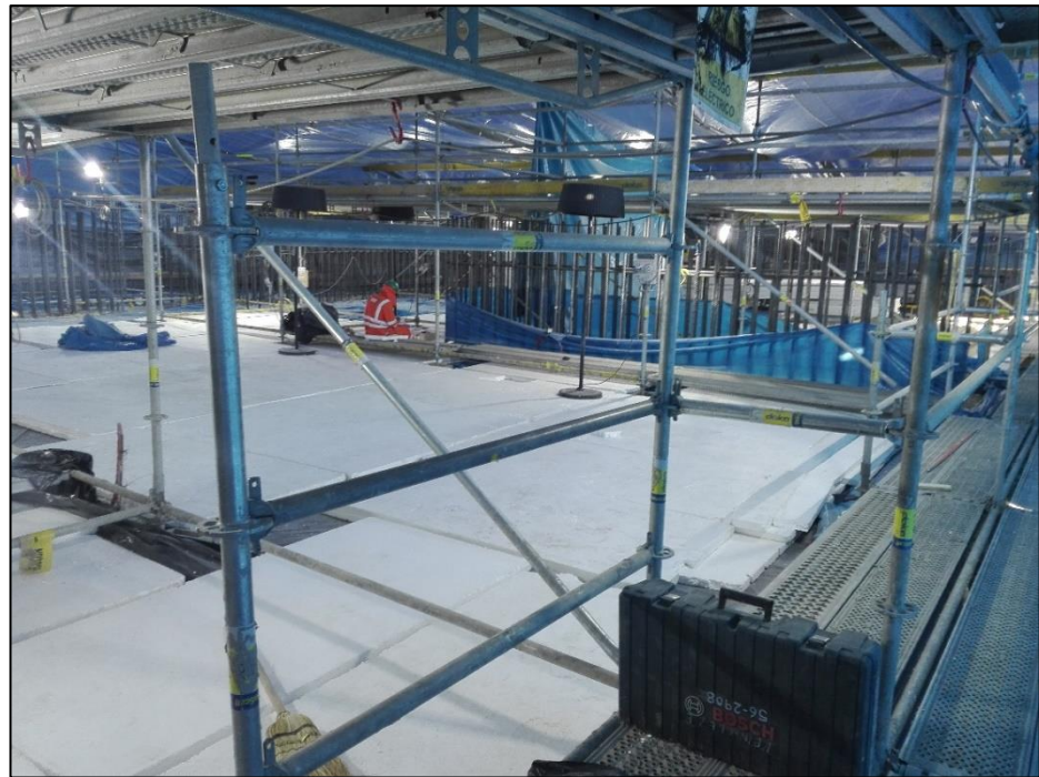
Figura 30. Protección térmica superficial de poliestireno en cimentación de Molino de Bolas 01, previo a la cubierta final de polietileno
