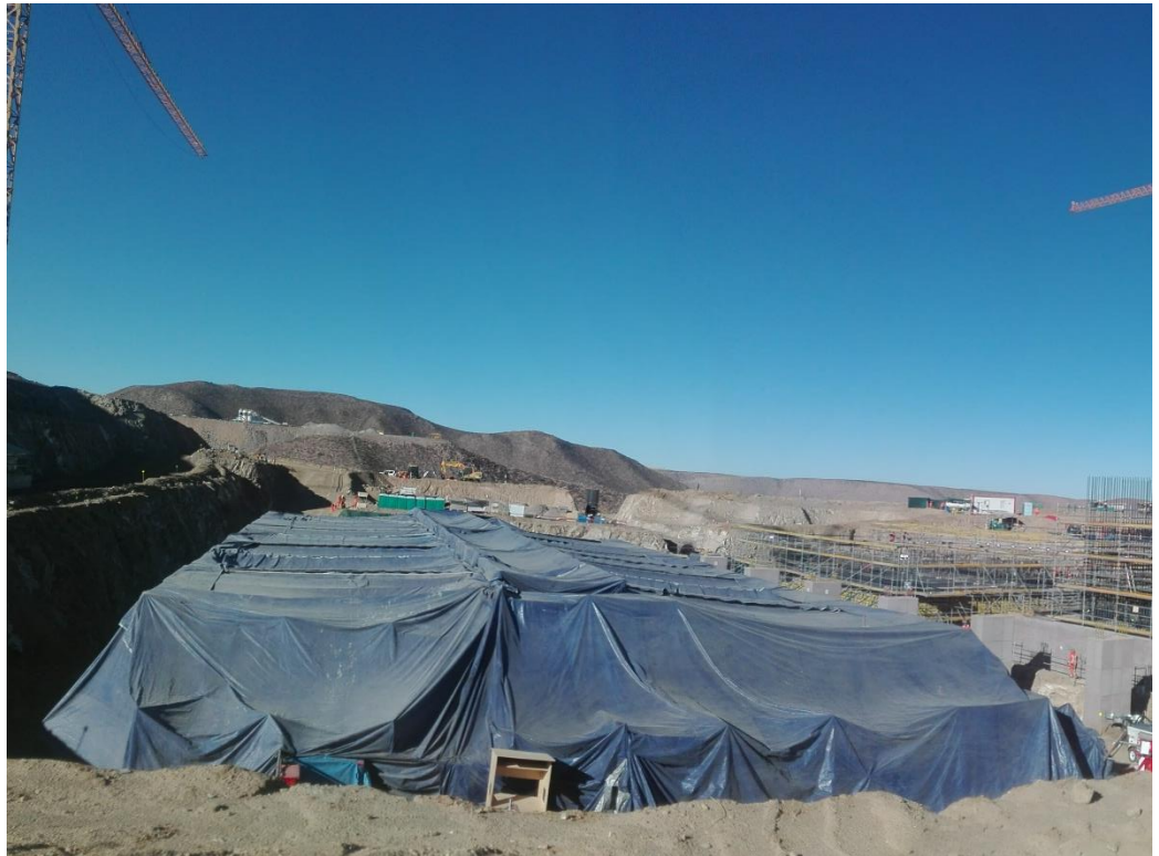
Figura 40. Fotografía de microclima implementado en campo para Cimentación de Molino SAG 02.
