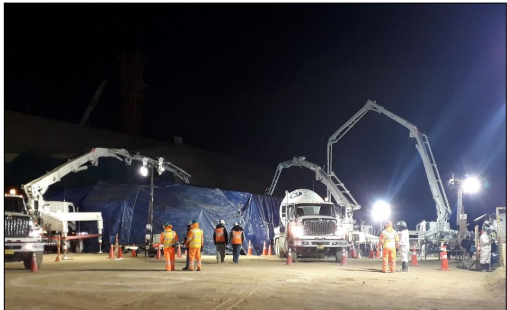
Figura 47. Fotografía de microclima ejecutado en campo para la Cimentación del Túnel de Recuperación (Etapa 01)
