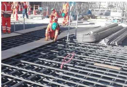
Figura 17 y 18. Termocupla instalada previo al vaciado, el sensor está ubicado a la profundidad requerida y el cable protegido del concreto mediante cinta roja.
