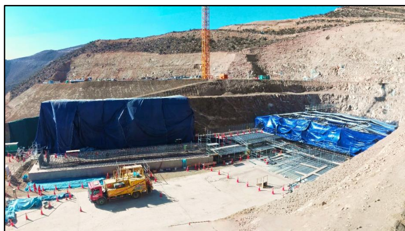
Figura 9. Túnel de Recuperación y Muro Etapa 01.
