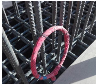
Figura 17 y 18. Termocupla instalada previo al vaciado, el sensor está ubicado a la profundidad requerida y el cable protegido del concreto mediante cinta roja.
