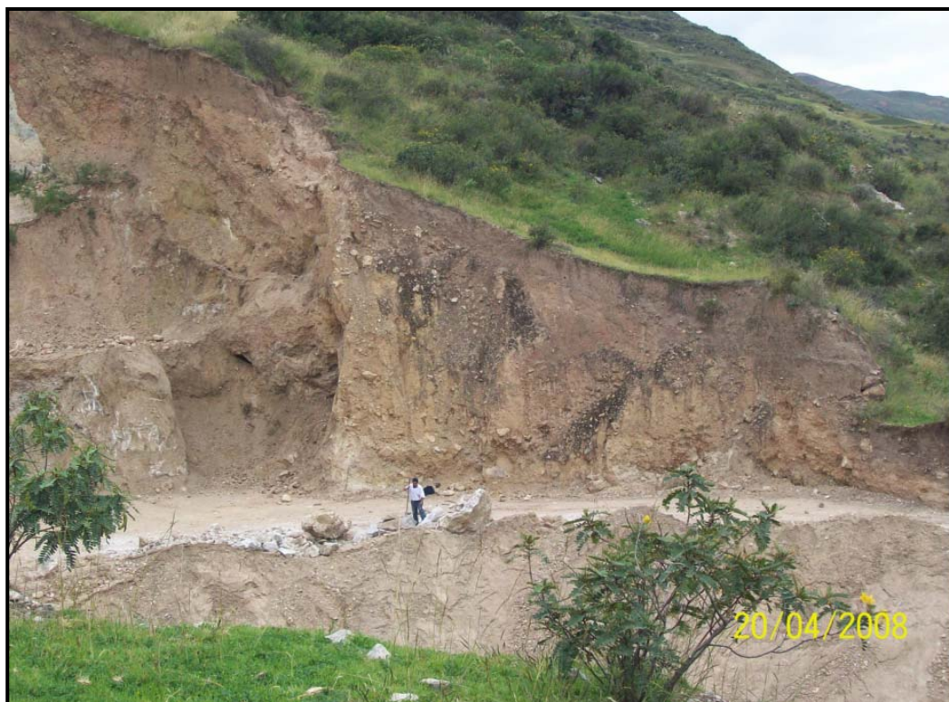
Vista N° 27: Trabajador en plena labor en la Cantera
