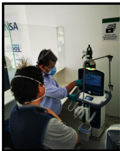
Figura 21: Revisión del Equipo Instalado con Personal Técnico y Especialistas del GOREHCO. Fuente: Propia
