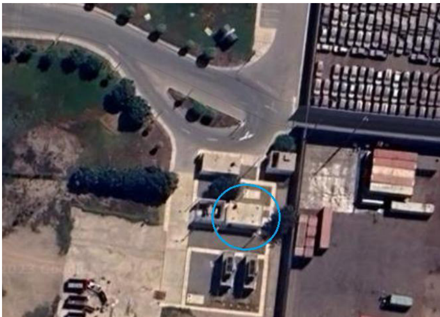
Figura 19 Sala MT de 4.16kV frente a grupos de generación. Fuente. Datos tomados de aplicación Google Earth (2024).
