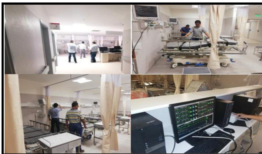
Figura 40: Ubicación de los monitores y central de monitoreo. Fuente: Elaboración propia
