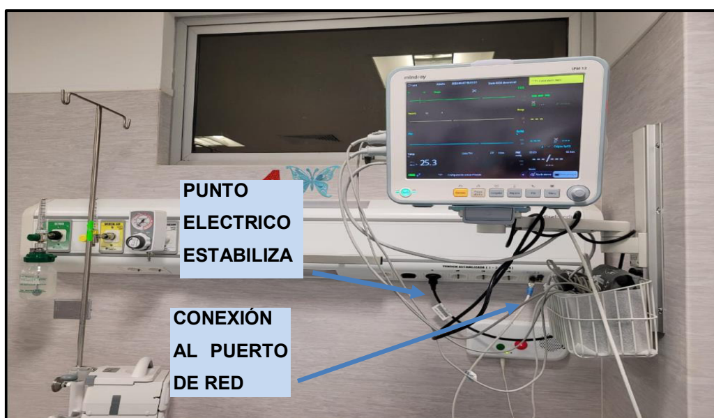
Figura 39: Instalación y ubicación del MSV. Fuente: elaboración propia
