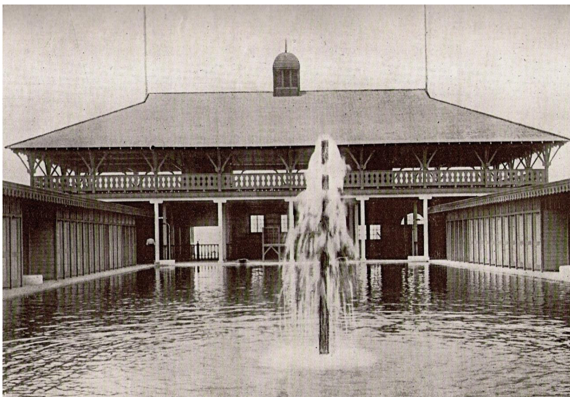
Figura 35. Otra vista de los interiores del establecimiento de los baños. Se aprecia la pileta que alimentaba la piscina y la terraza para el público, en donde se celebraban diversas actividades. Fuente: La Prensa , año X, nro. 5024, 19 de enero de 1913, p. 1.
