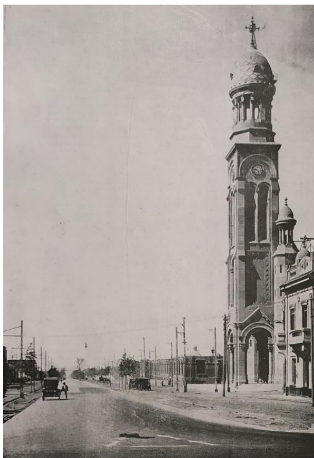
Figura 5. Fotografía de la av. Magdalena en 1925, cuando ya recibía el nombre de av. Brasil. Se puede apreciar la recientemente pavimentada calle central, la línea del tranvía eléctrico en los bordes y la torre del templo de María Auxiliadora. Fuente: Ciudad y Campo y Camino , Lima, nro. 13, diciembre de 1925.
