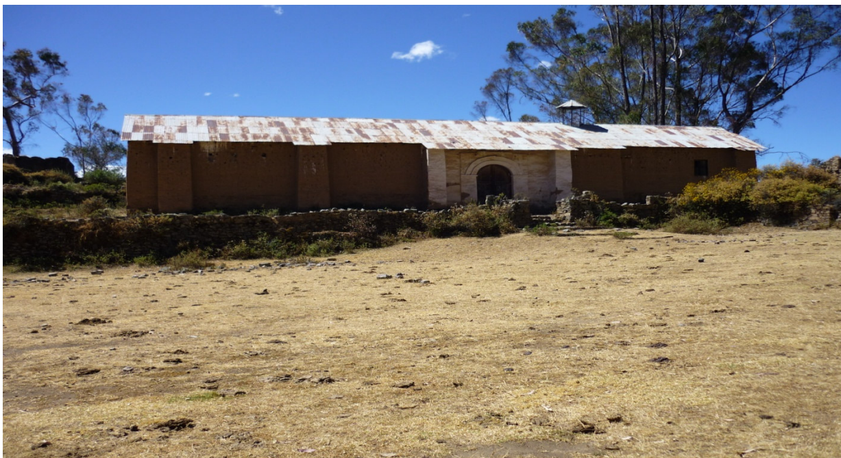
Figura 11: Parte lateral de la antigua iglesia de Santiago de Maray en "Maray viejo". Elaboración Nelsi Mallqui (2017).
