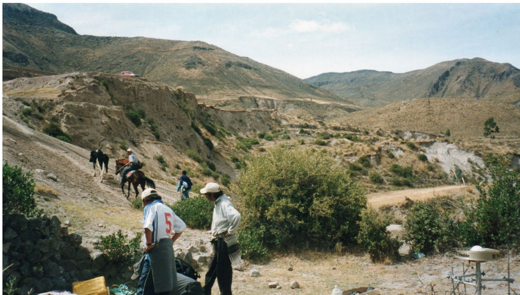
Figura 77. Sitio GPS MAD4 parte baja escarpa principal deslizamiento Ushina
