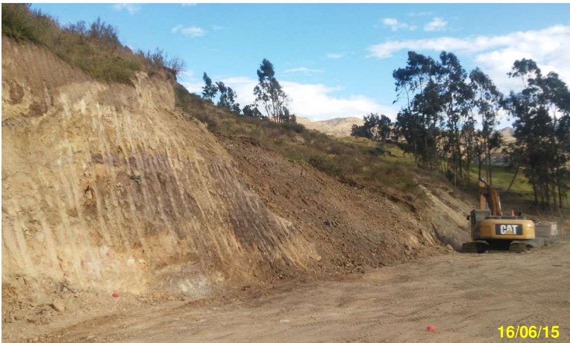
Foto N° 10. Excavaciones en el talud
