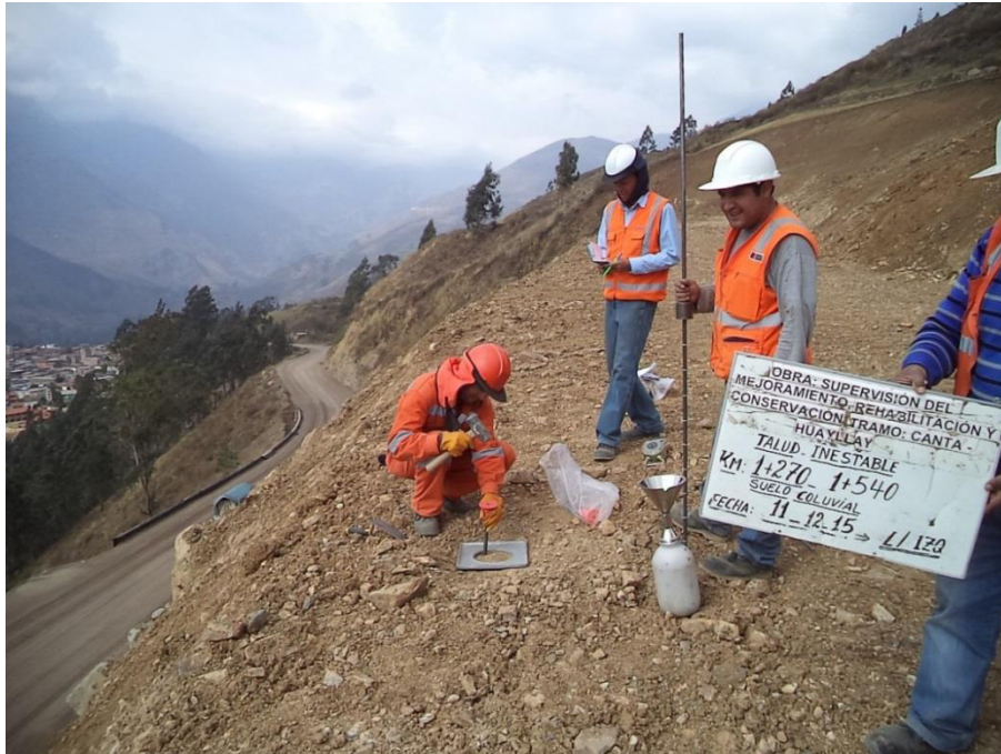
Foto N° 4.6. Ensayo de Cono de Arena y DPL Km 102+770 – 103+040. Suelo Coluvial
