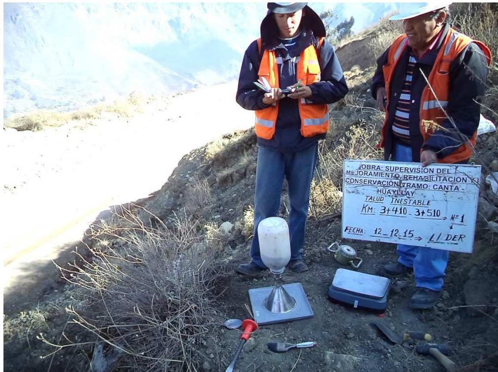
Foto N° 4.10. Ensayo de Cono de Arena Km 104+920 – 105+010.
