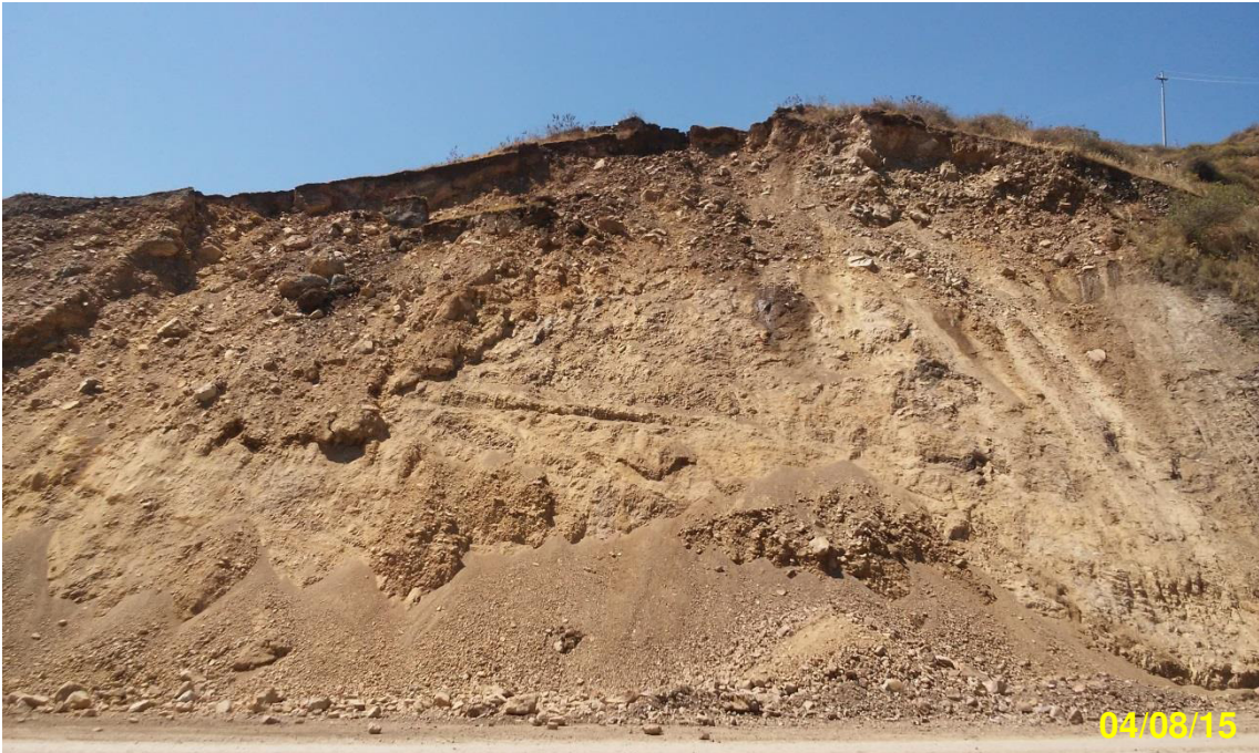
Foto N° 5. Talud después de ejecutado el corte de 1:1 (H:V)
