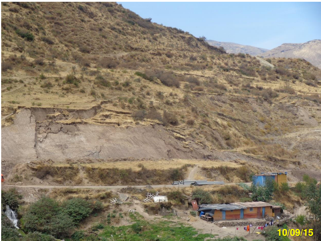
Foto N° 20. Vista de deslizamientos y agrietamientos desde la parte superior.
