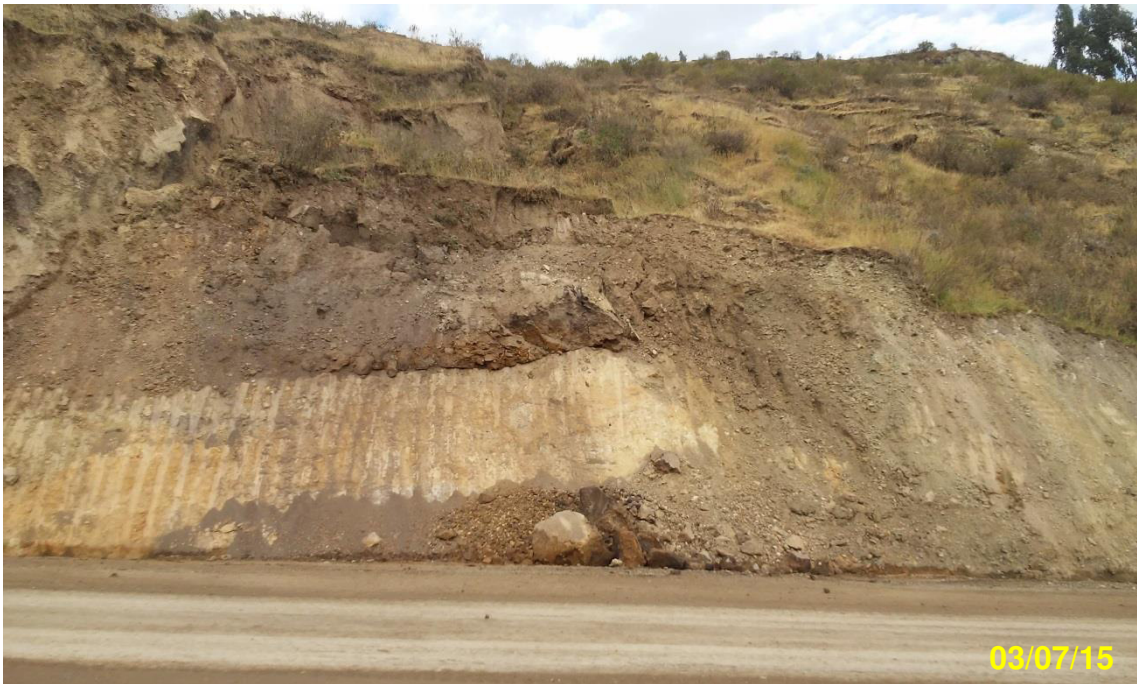
Foto N° 11. Deslizamientos y reptación de suelos superficiales en la ladera.
