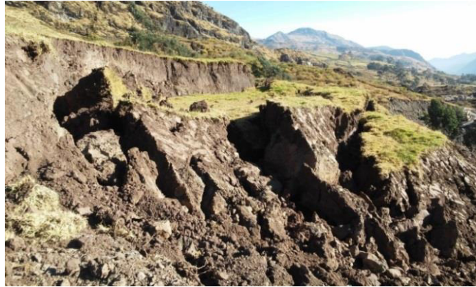
Foto N° 4.3. Deslizamientos rotacionales paralelos Km 107+860
