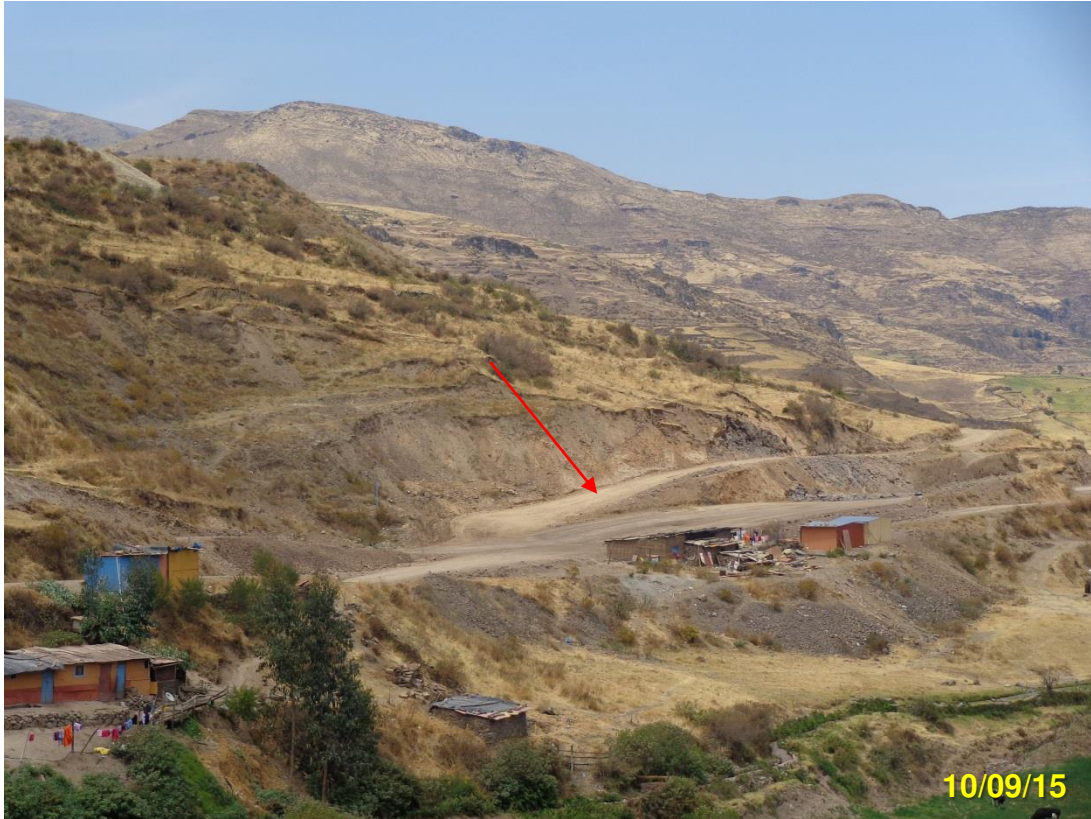
Foto N° 19. Vista del acceso a Cantamarca
