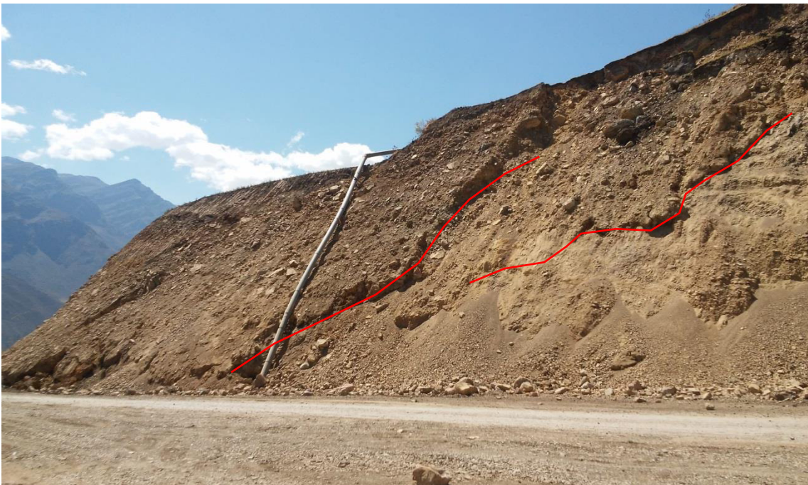
Foto N° 6. Vista de los materiales conformantes del talud
