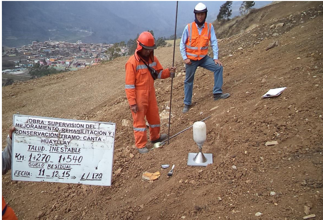
Foto N° 4.9. Ensayo de Cono de Arena y DPL Km 102+770 – 103+040. Suelo Coluvio-Aluvial
