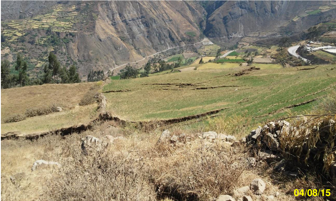
Foto N° 7. Toma desde arriba de la ladera con grietas tensionales escalonadas.
