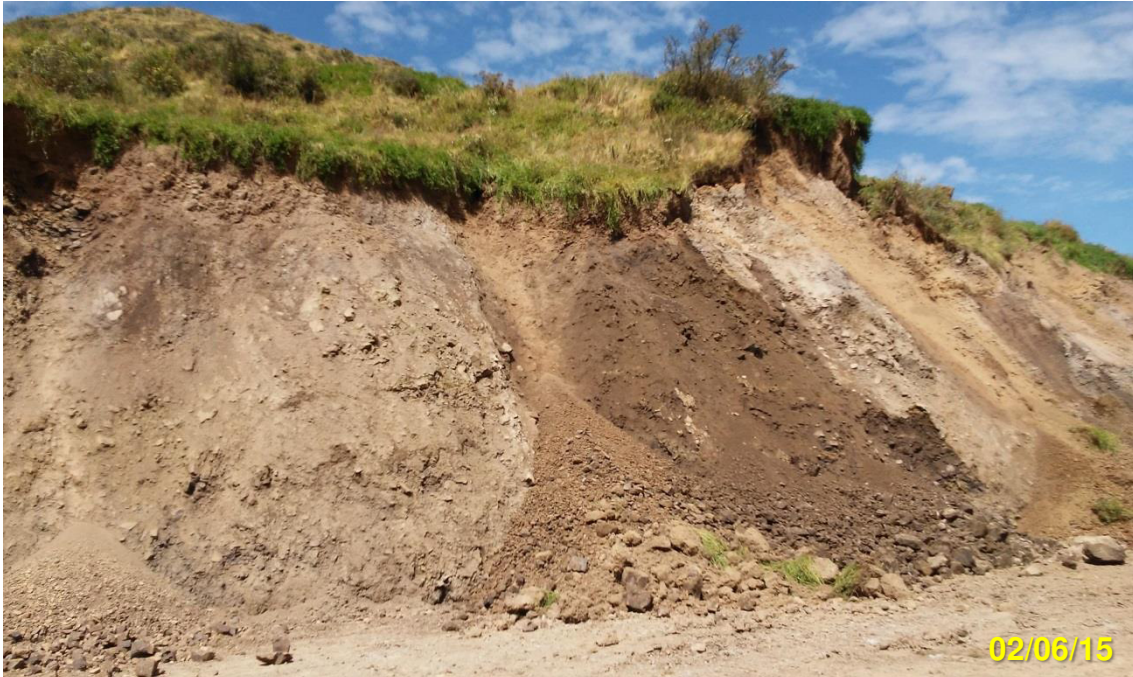
Foto N° 15. Pequeños deslizamientos después de ejecutada la excavación de talud (1:2, H:V)
