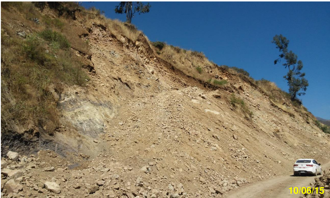
Foto N° 2. Inicio de cortes en la parte superior del talud
