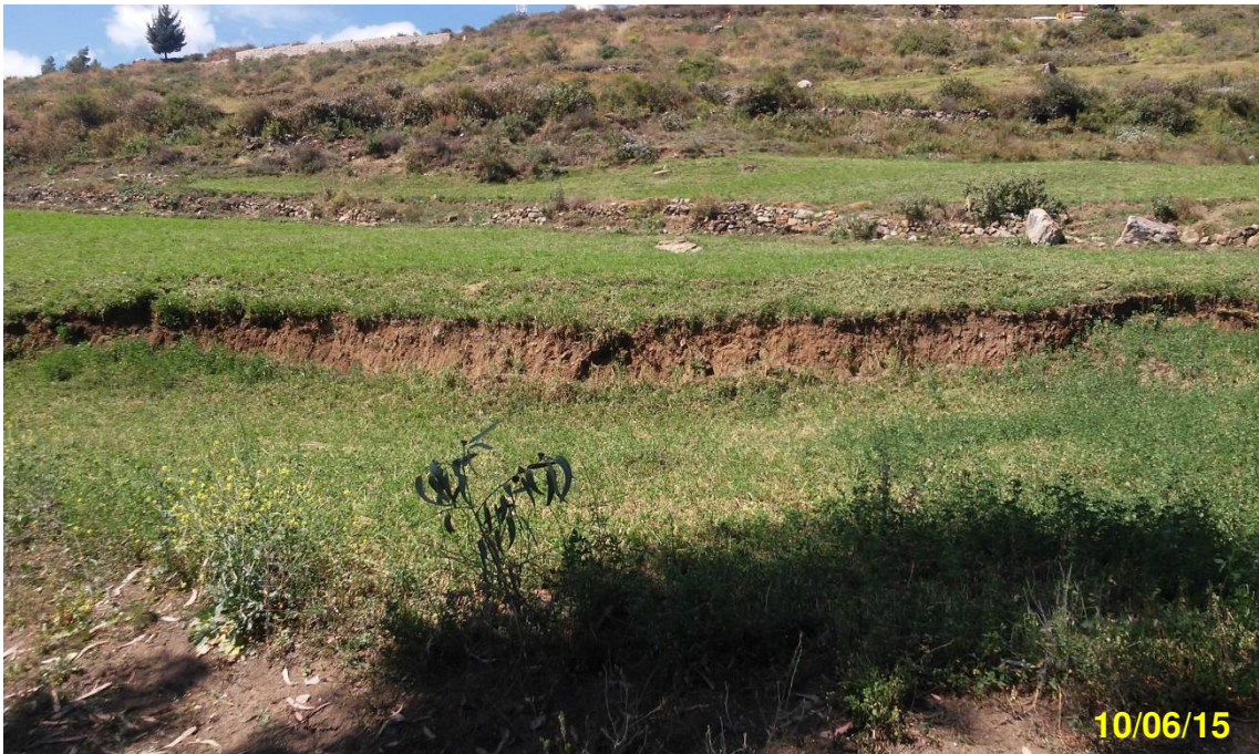
Foto N° 4. Vista del agrietamiento y desplazamiento del terreno en la ladera superior
