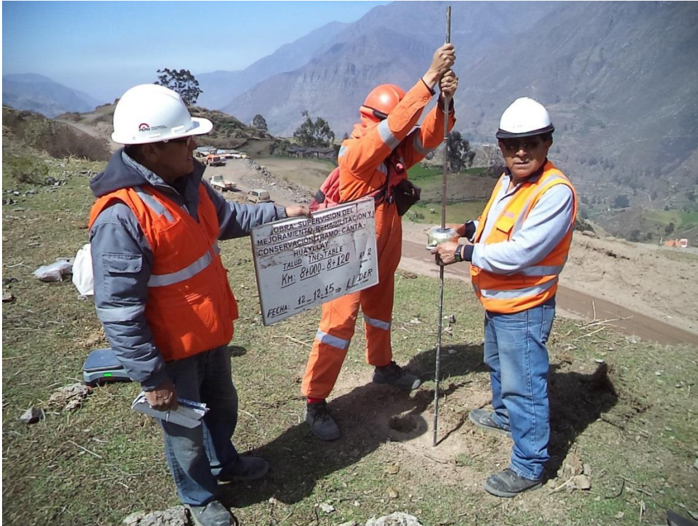
Foto N° 4.8. Ensayo de DPL Km 109+500 – 109+620.
