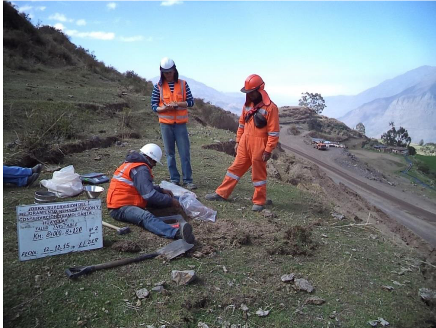
Foto N° 4.11. Ensayo de Cono de Arena Km 109+500 – 109+620.
