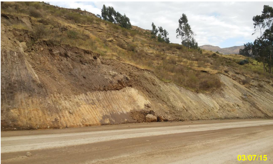
Foto N° 12. Vista lateral de los deslizamientos y reptación en la ladera.
