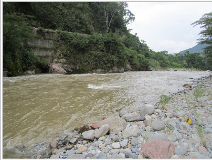
Figura N° 4.4: Margen derecha e izquierda en la zona de interés del río Tulumayo
