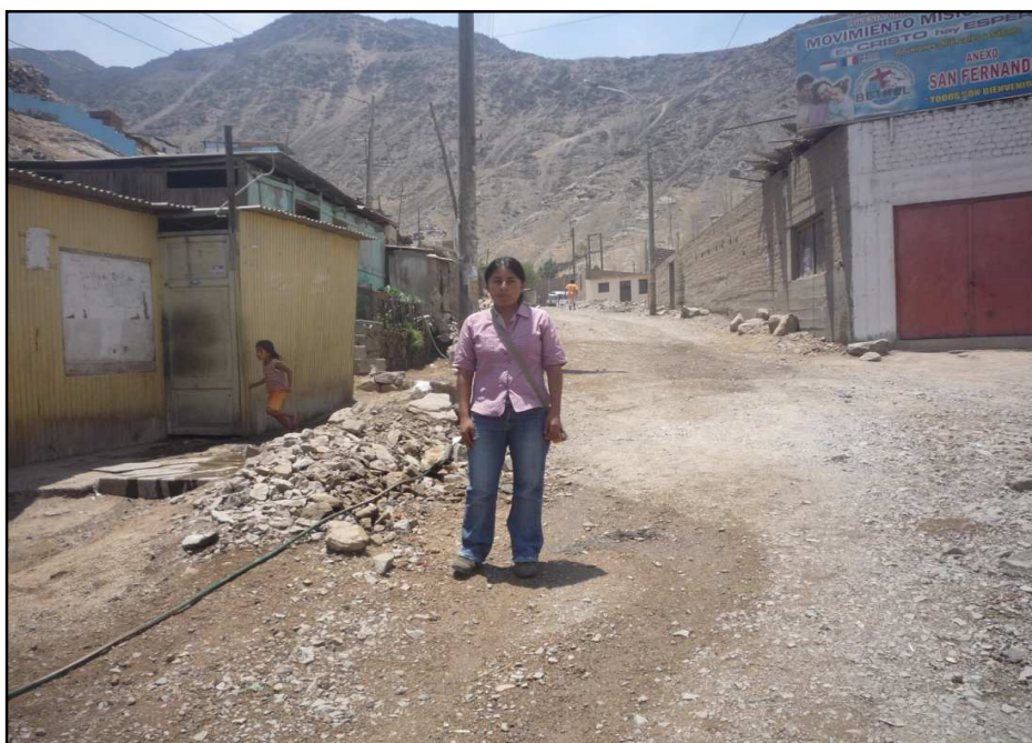
Asentamiento Humano San Fernando - San Juan de Lurigancho, se observa la precaria ruta de acceso a las viviendas.
