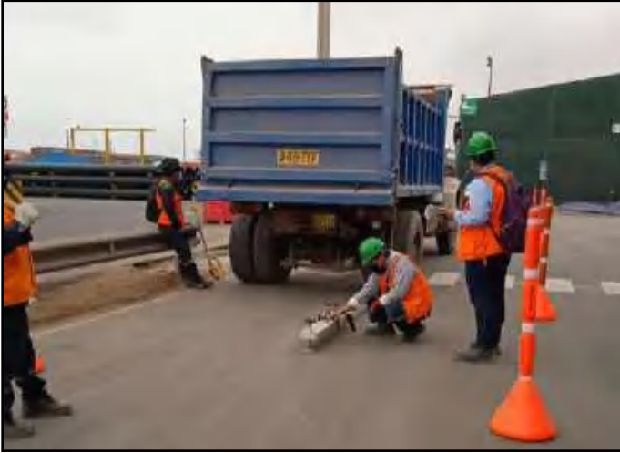
Fotografía N° 043 – Sector 04 KM 00+000 - KM 00+130
