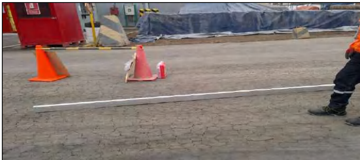
Fotografía N° 017: Sector 03 Km 00+000 - Km 00+097
