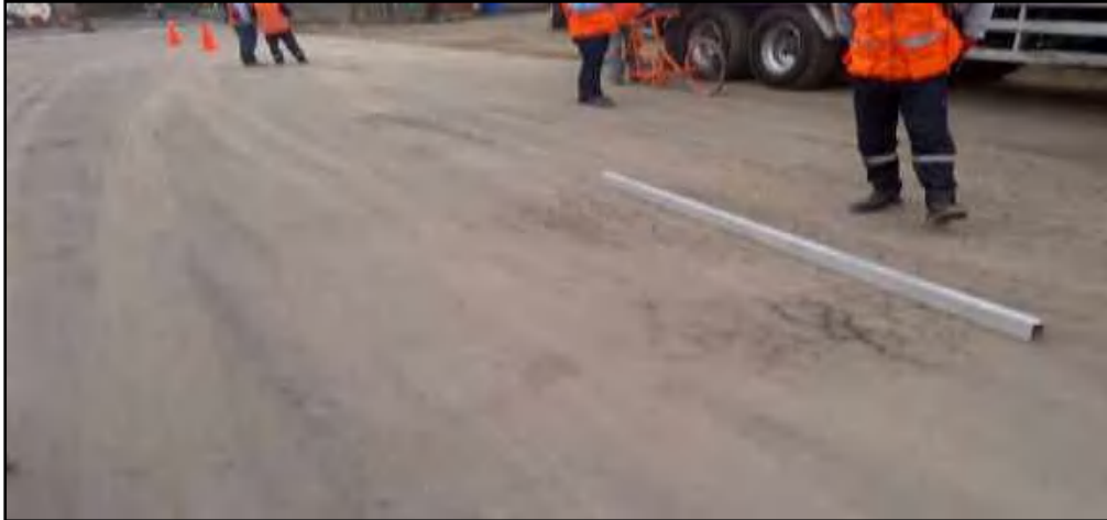
Fotografía N° 006: Sector 03 Km 00+000 - Km 00+097
