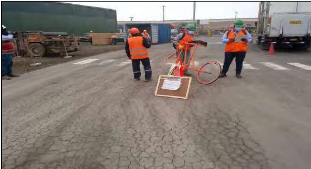
Fotografía N° 042: Sector 03 Km 00+000 - Km 00+097
