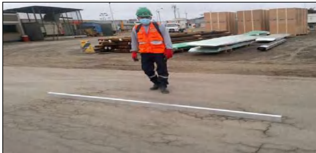
Fotografía N° 013: Sector 03 Km 00+000 - Km 00+097
