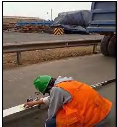
Fotografía N° 046 – Sector 04 KM 00+000 - KM 00+130
