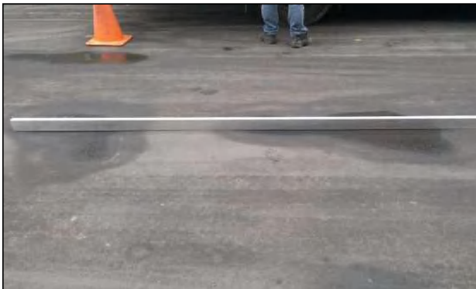
Fotografía N° 025: Sector 04 Km 00+000 - Km 00+130
