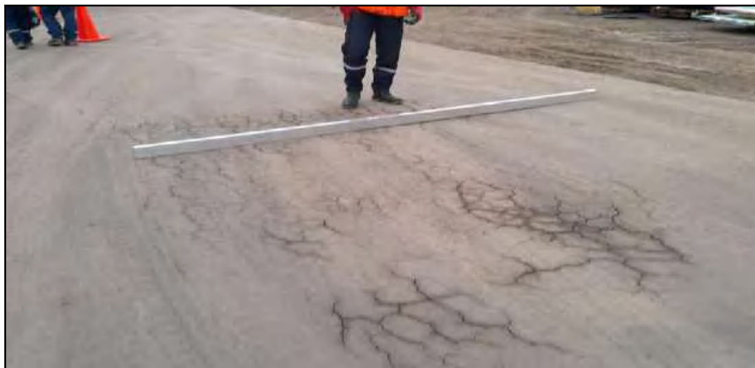
Fotografía N° 012: Sector 03 Km 00+000 - Km 00+097
