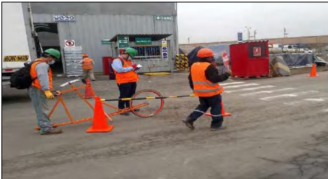
Fotografía N° 039: Sector 03 Km 00+000 - Km 00+097
