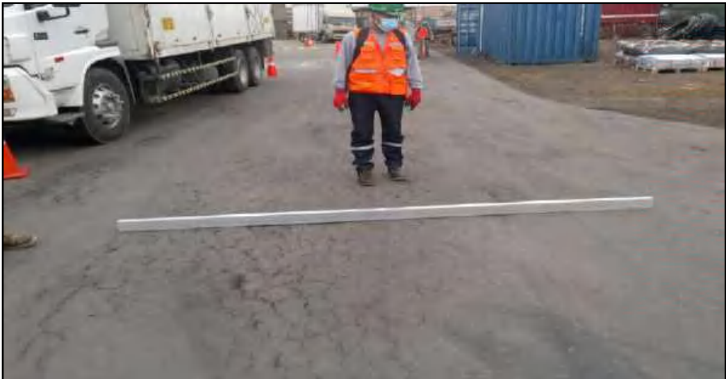
Fotografía N° 019: Sector 03 Km 00+000 - Km 00+097
