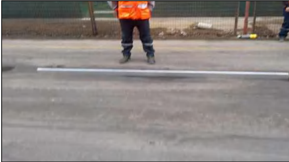
Fotografía N° 023: Sector 04 Km 00+000 - Km 00+130
