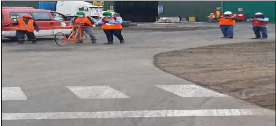
Fotografía N° 05: Sector 02 Km 00+000 - Km 00+046
