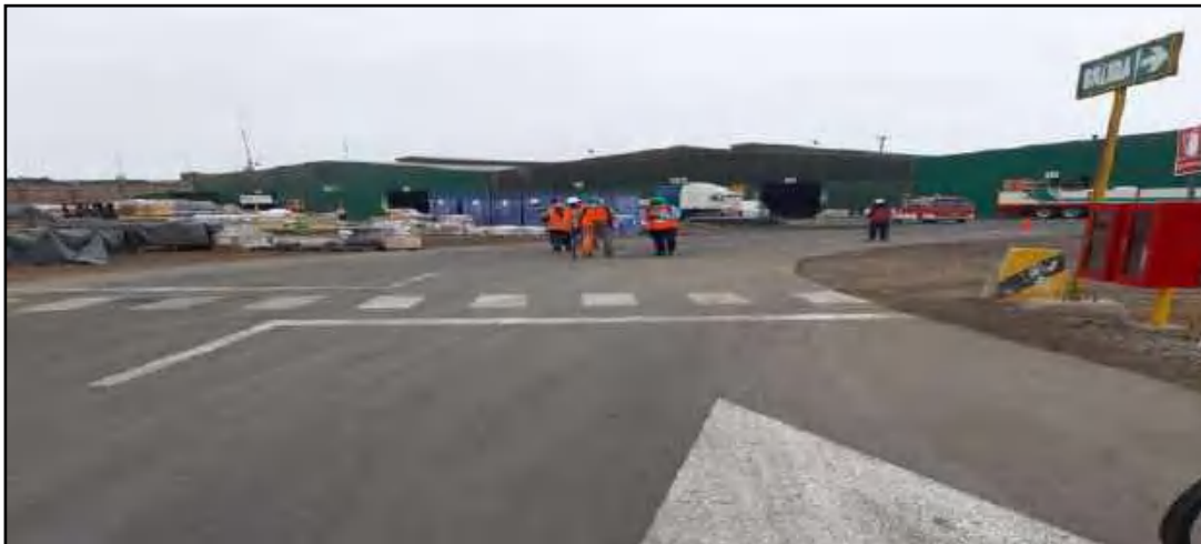
Fotografía N° 002: Sector 02 Km 00+000 - Km 00+046
