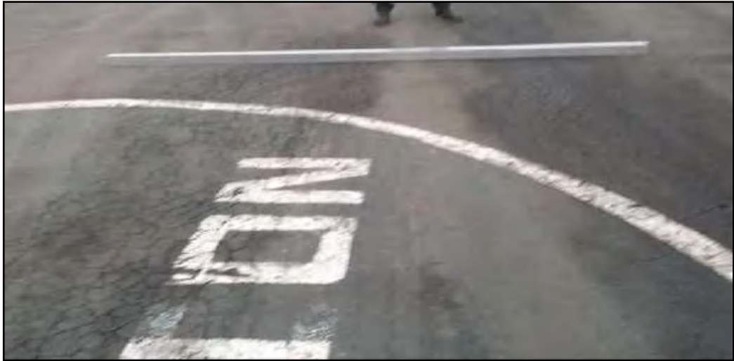
Fotografía N° 018: Sector 03 Km 00+000 - Km 00+097
