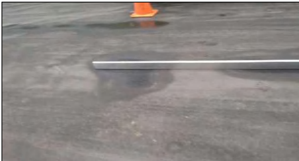
Fotografía N° 027: Sector 04 Km 00+000 - Km 00+130
