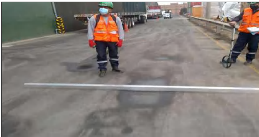
Fotografía N° 032: Sector 04 Km 00+000 - Km 00+130
