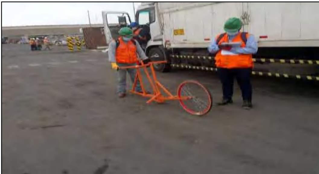
Fotografía N° 038: Sector 03 Km 00+000 - Km 00+097
