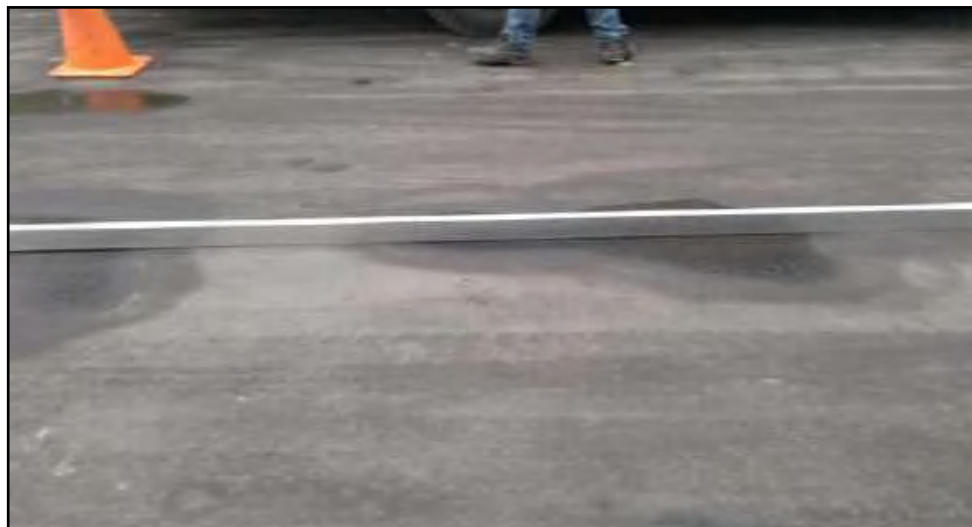
Fotografía N° 026: Sector 04 Km 00+000 - Km 00+130
