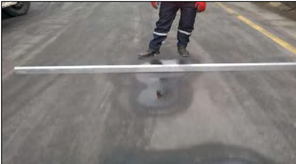
Fotografía N° 024: Sector 04 Km 00+000 - Km 00+130
