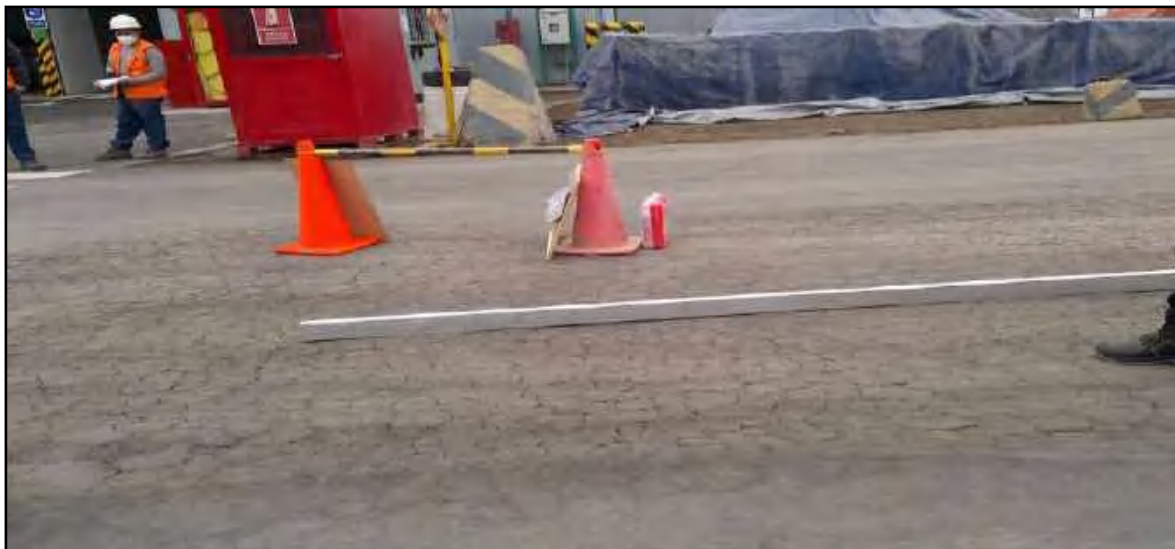
Fotografía N° 016: Sector 03 Km 00+000 - Km 00+097
