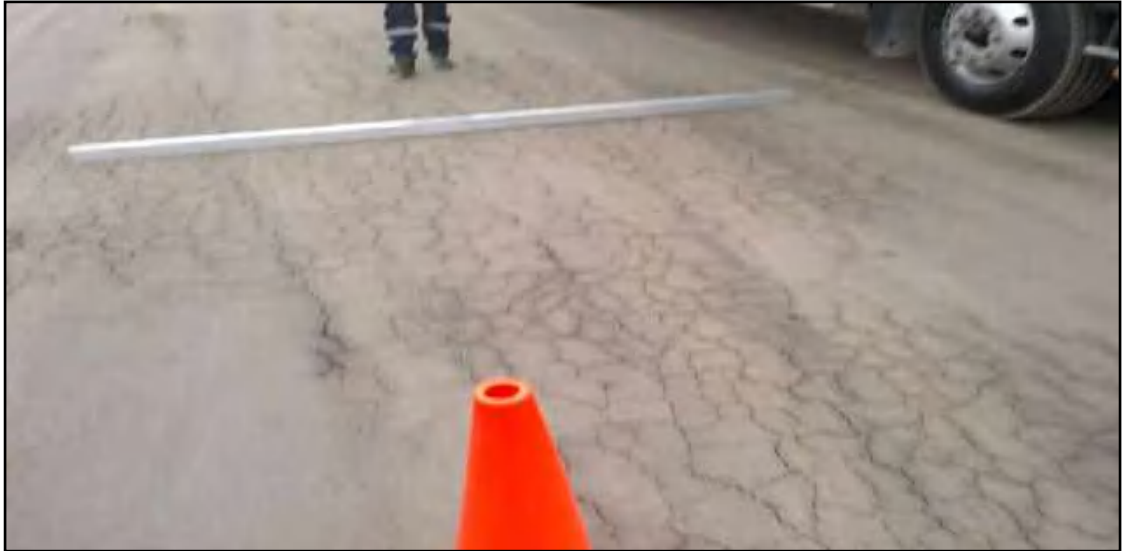
Fotografía N° 014: Sector 03 Km 00+000 - Km 00+097
