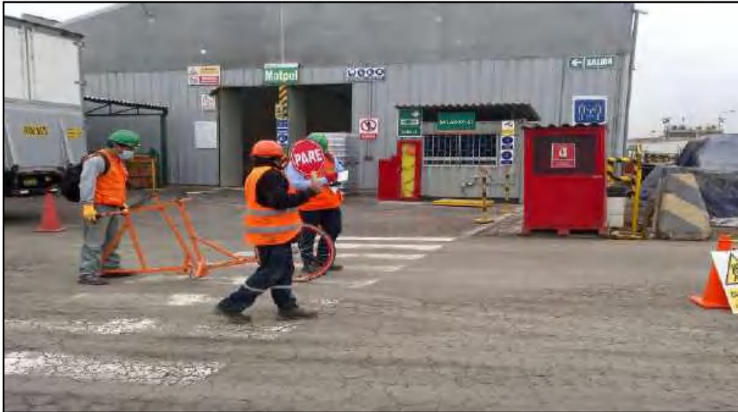
Fotografía N° 041: Sector 03 Km 00+000 - Km 00+097
