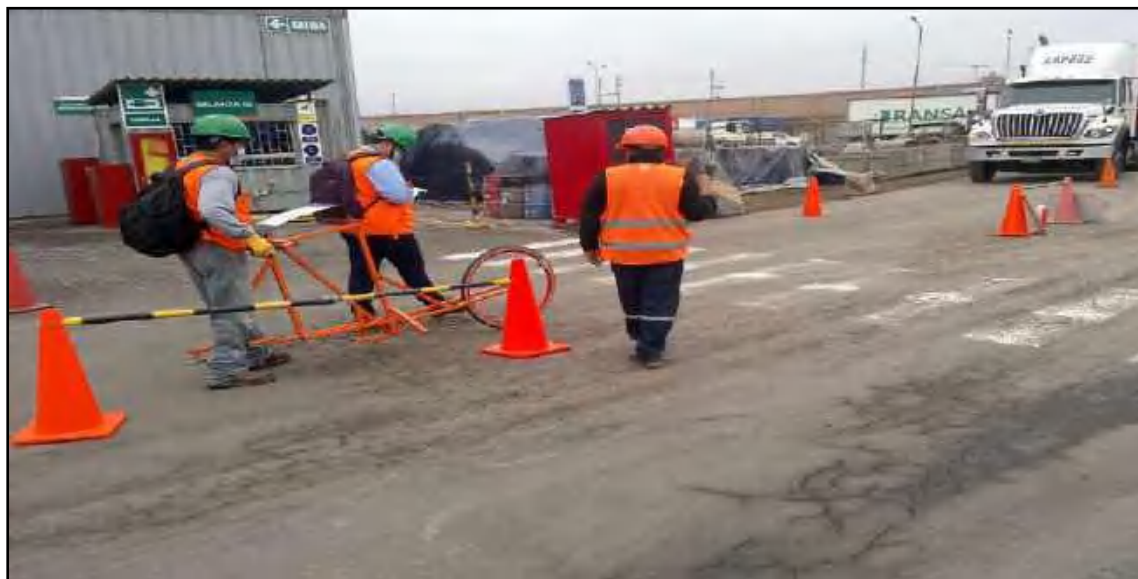
Fotografía N° 040: Sector 03 Km 00+000 - Km 00+097
