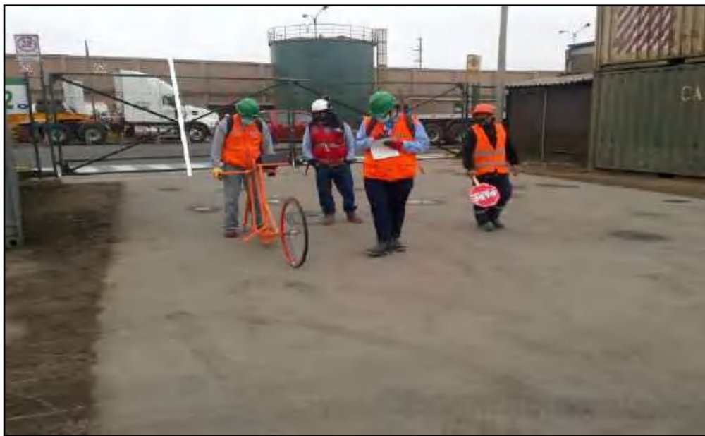
Fotografía N° 035: Sector 03 Km 00+000 - Km 00+097
