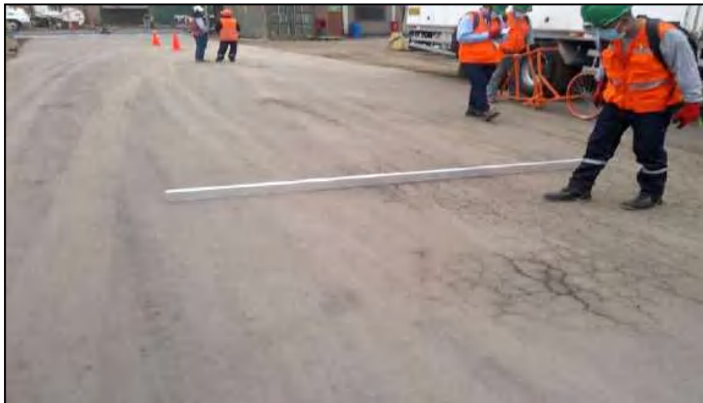
Fotografía N° 007: Sector 03 Km 00+000 - Km 00+097
