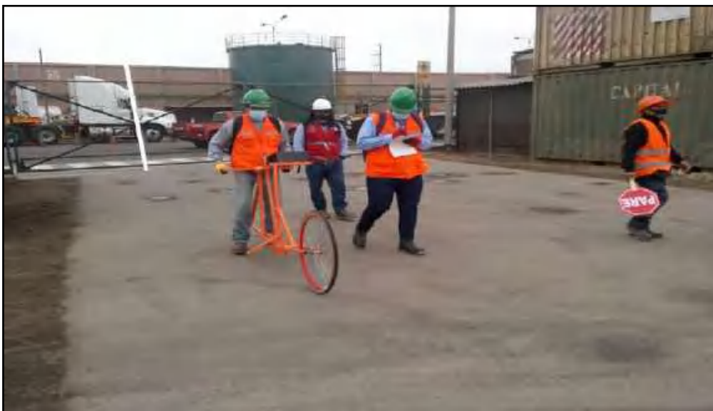
Fotografía N° 036: Sector 03 Km 00+000 - Km 00+097
