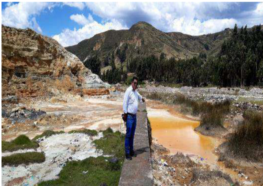
Figura 5.10 Formación de pequeñas cárcavas en laderas del relave, con pendiente pronunciada, generando contaminación al río Santa.
