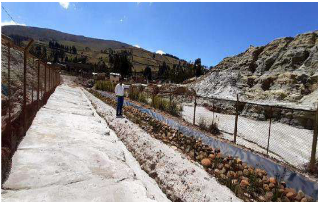
Figura: 1.5 Vista del relave bisectado en dos, se observa drenando agua al río Santa son de precipitaciones pluviales.
