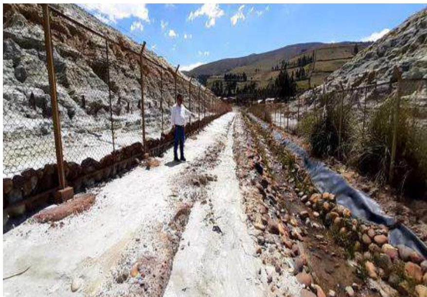
Figura 5.9 Agua producto de precipitación pluvial tributando al río santa.
