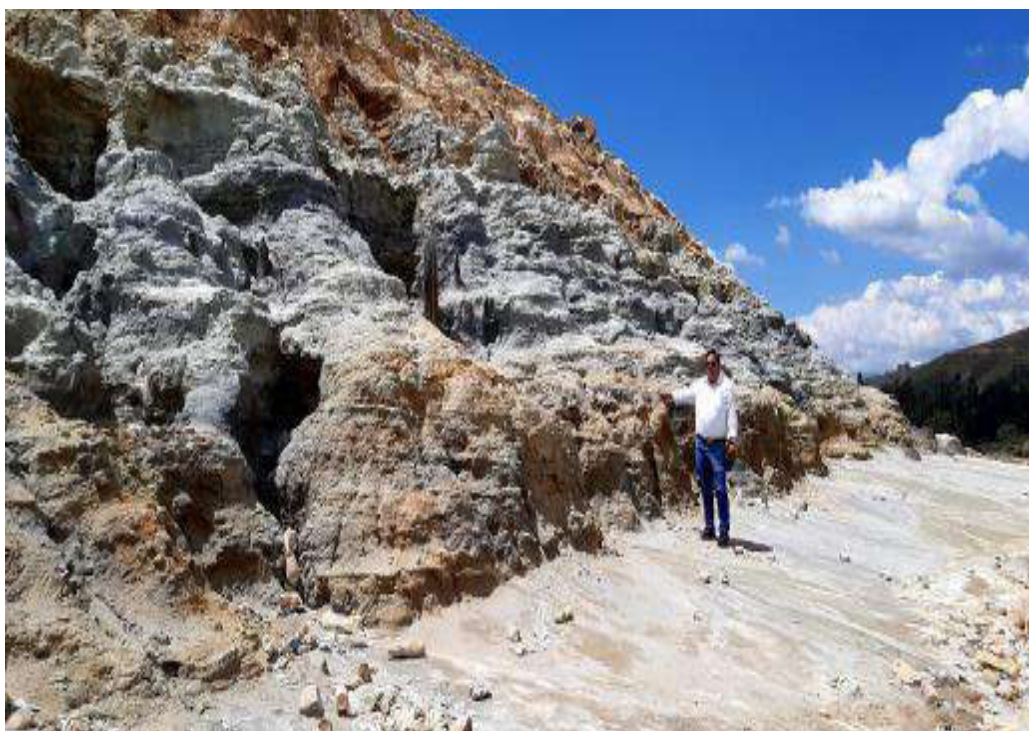
Figura: 1.6 Capas del relave Ticapampa, se viene formando pequeñas cárcavas por las precipitaciones pluviales orientadas al río santa.
