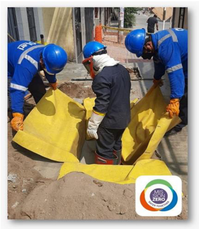
Figura 11. Personal acondiciona la zanja con las mantas dieléctricas para que el operario que tiene todos sus EPP dieléctricos pueda ejecutar el trabajo con riesgo eléctrico
