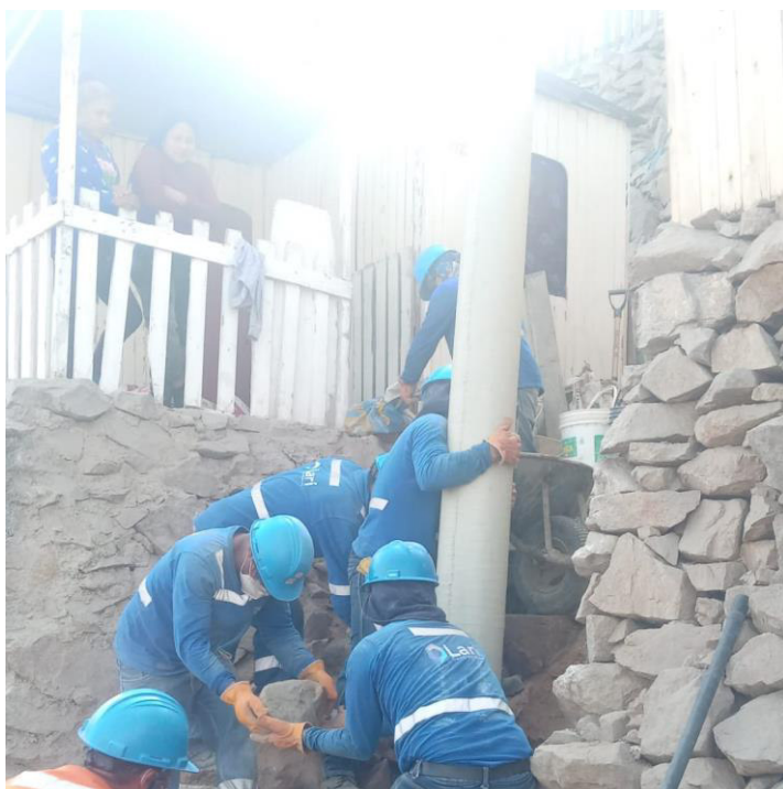
Figura 5. Personal expuesto a aplastamiento, cortes por poste. Nota: Imágenes obtenidas por el investigador durante el proceso de observación.
