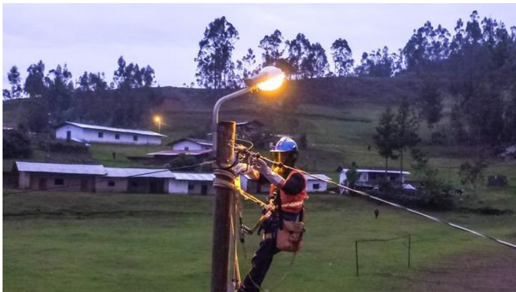
Figura 3. Alumbrado público en centro poblado rural - Fuente: Propia
