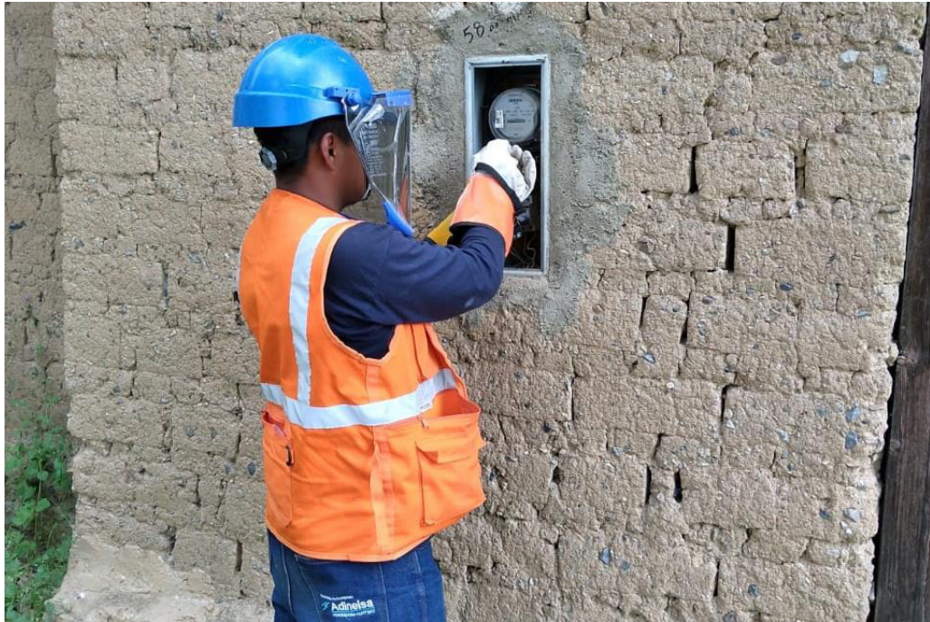
Figura 4. Personal ejecutando reemplazo de medidores - Fuente: Propia
