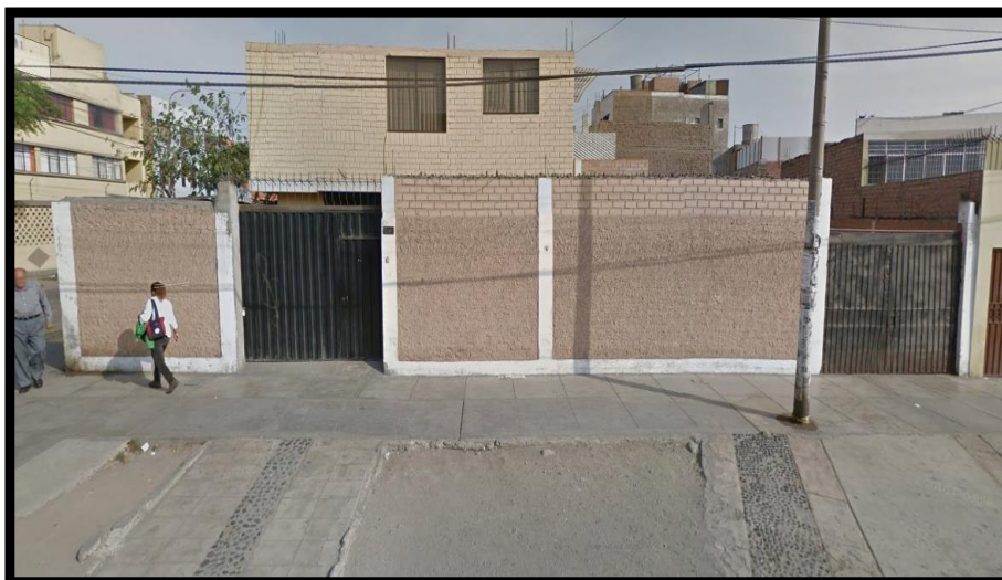
Figura 18: Exteriores del almacén de Lima
