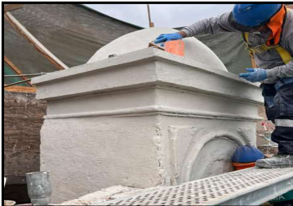
Fotografía N°43: Restitución de revoque de cal en Sector 02
