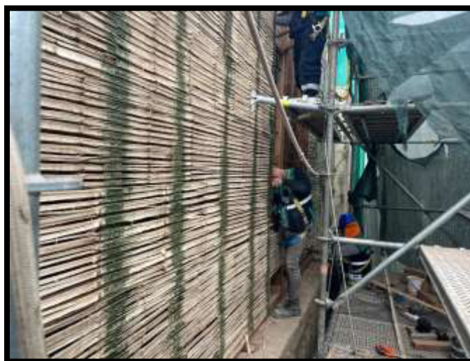
Fotografía N°38: Restitución de telares de quincha en Sector 02
