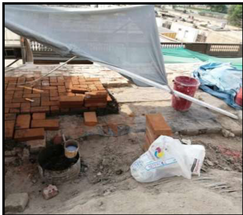
Fotografía N°64: Restitución de ladrillos pasteleros en Sector 04
