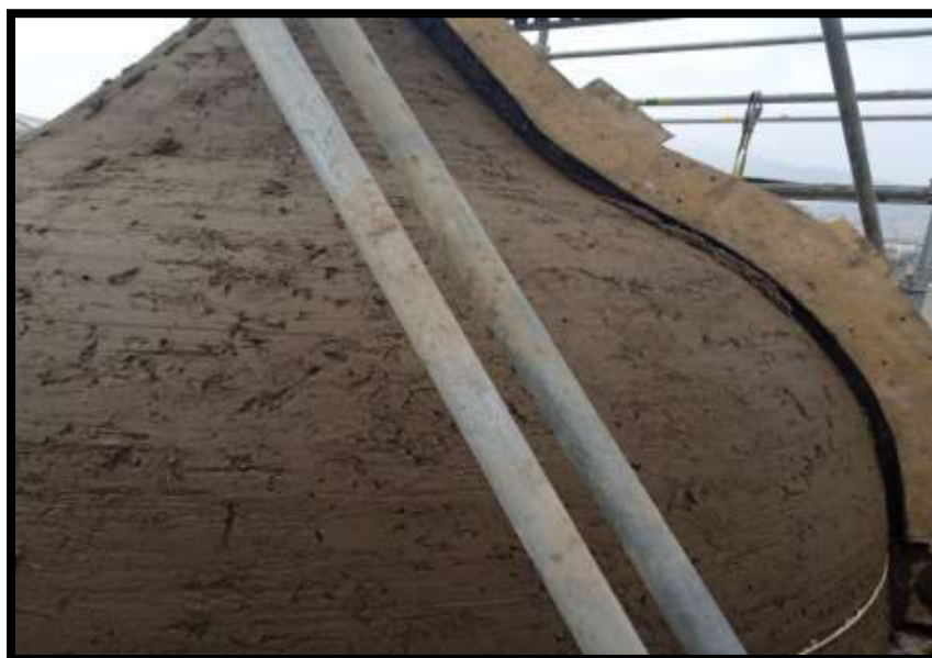
Fotografía N°50: Restitución de revoque de barro en cupulines de Sector 01
