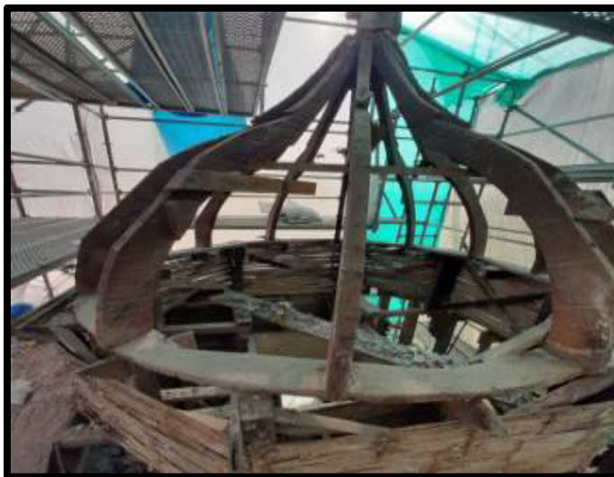
Fotografía N°07: Liberación de caña chancada incompatible en Sector 01
