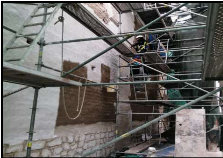
Fotografía N°41: Restitución de enlucido de cal en Sector 02
