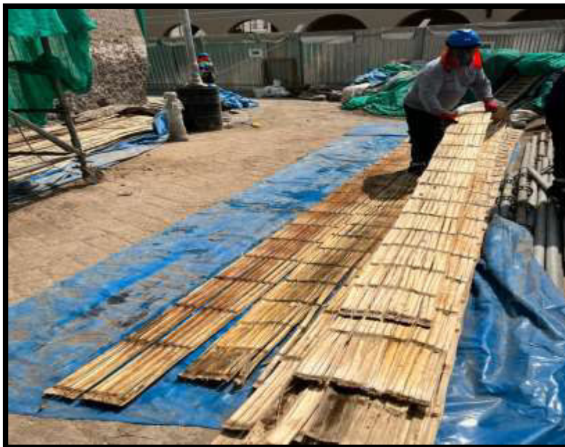
Fotografía N°35: Preservado de caña chancada para telares de quincha
