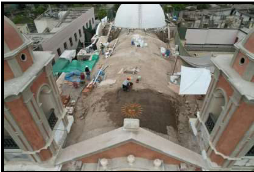
Fotografía N°63: Restitución de torta de barro en Sector 04
