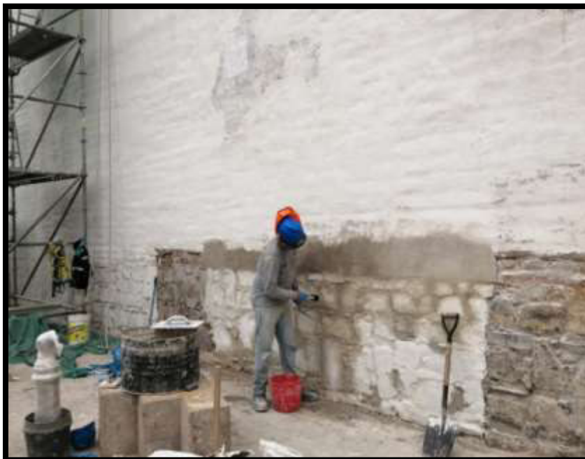
Fotografía N°55: Restitución de zócalo de piedra en Sector 02
