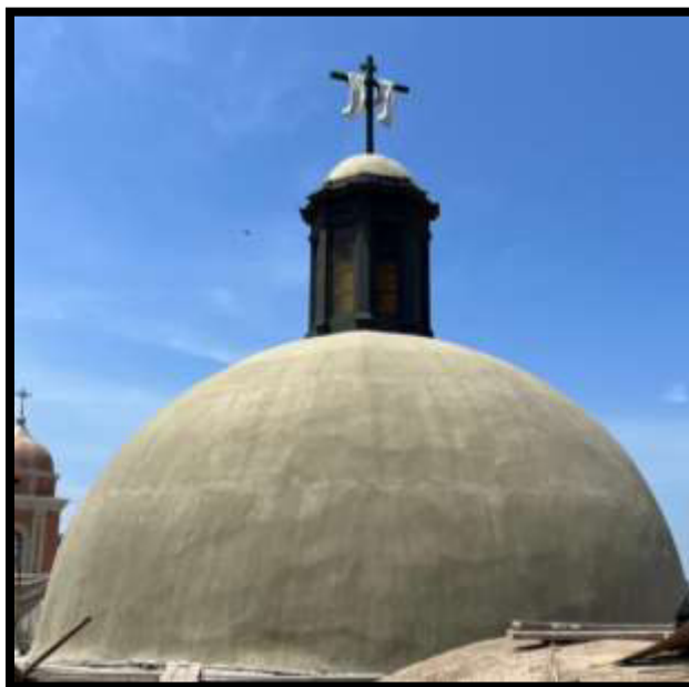
Fotografía N°60: Pintado de cúpula en Sector 04
