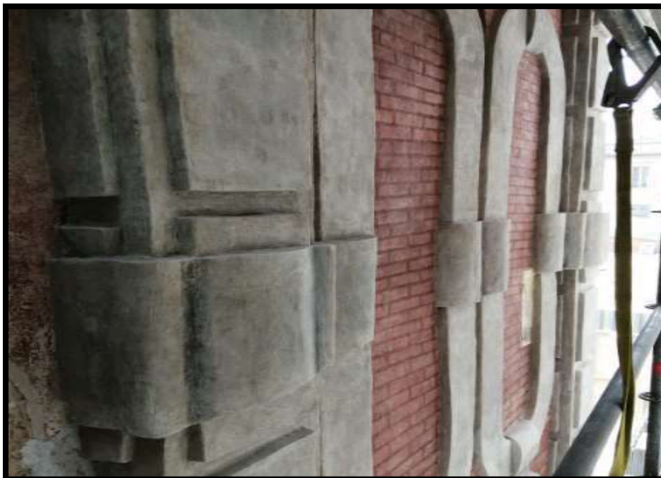
Fotografía N°45: Reintegración cromática de pintura mural en Sector 01
