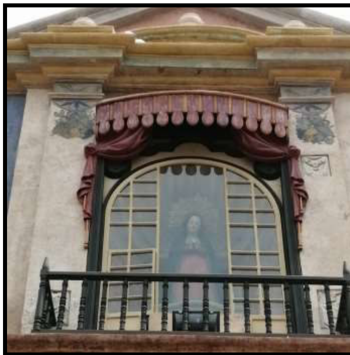
Fotografía N°62: Conservación de elementos ornamentales de madera en Sector 01
