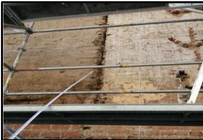
Fotografía N°11: Liberación de revoques incompatibles en Sector 02
