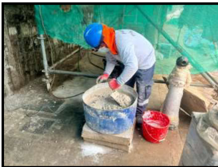
Fotografía N°34: Preparación de morteros de cal para revestimiento de muros
