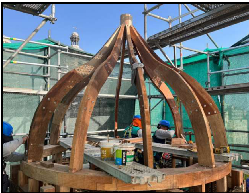
Fotografía N°48: Restitución de elementos ornamentales de madera en Sector 01
