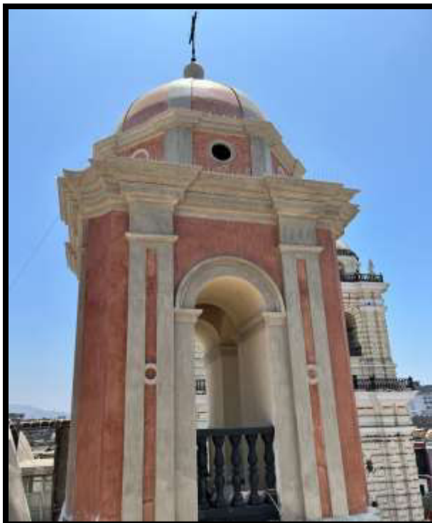
Fotografía N°59: Restitución de elementos ornamentales de madera en Sector 01
