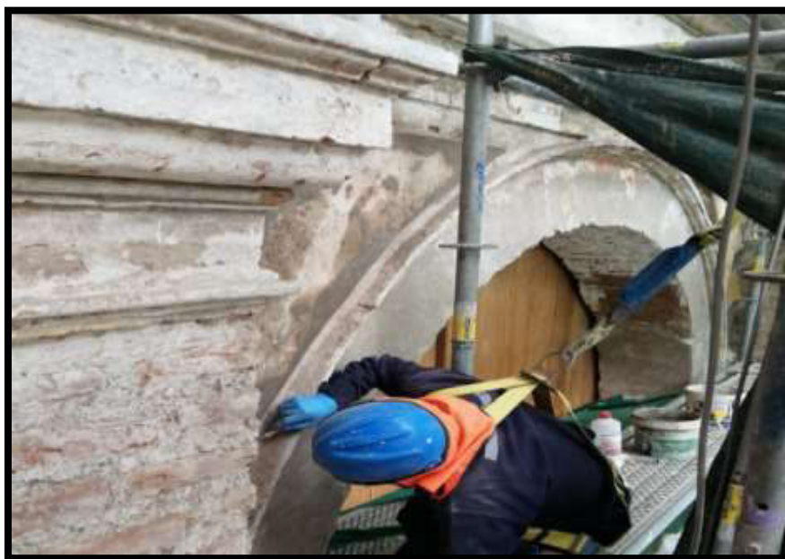
Fotografía N°42: Reintegración volumétrica de pintura mural en Sector 02
