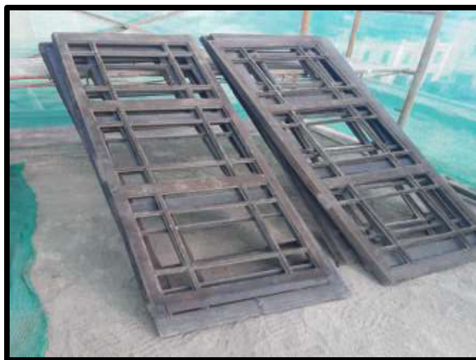
Fotografía N°04: Desmontaje de elementos ornamentales de madera en Sector 01
