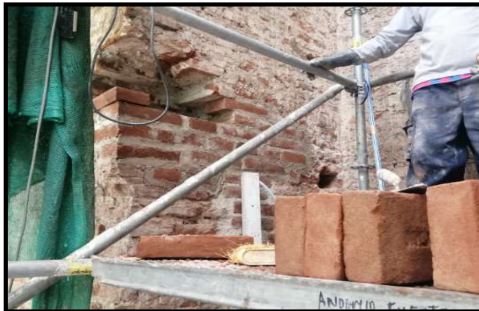
Fotografía N°66: Restitución de muros de ladrillo en Sector 02
