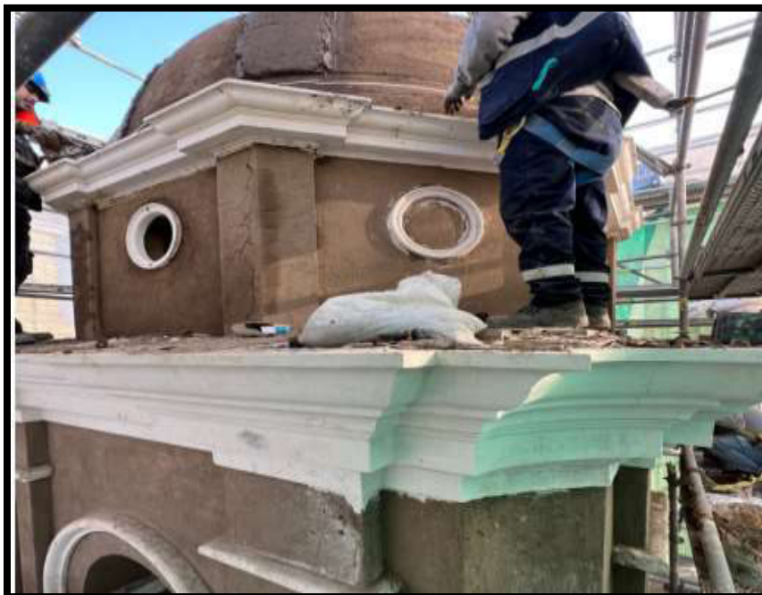
Fotografía N°51: Restitución de molduras en Sector 01
