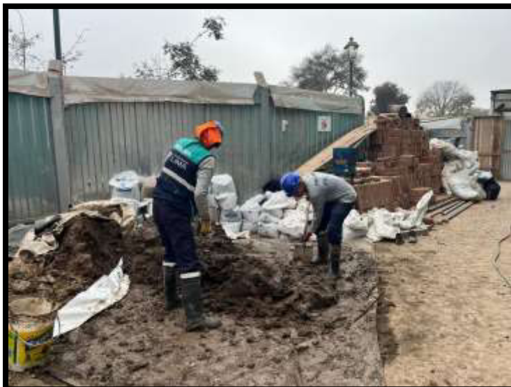
Fotografía N°33: Preparación de torta de barro para revestimientos
