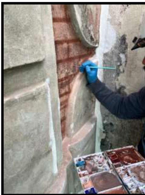
Fotografía N°26: Reintegración cromática de pintura mural en Sector 01
