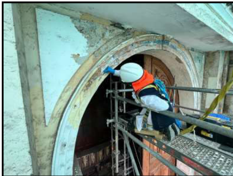
Fotografía N°19: Liberación de estratos superficiales en Sector 01
