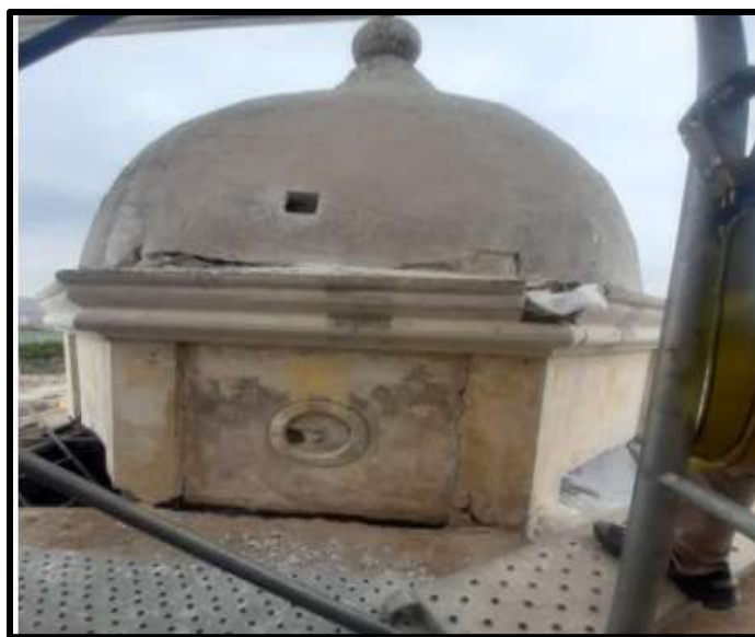
Fotografía N°02: Inspección visual en Sector 01
