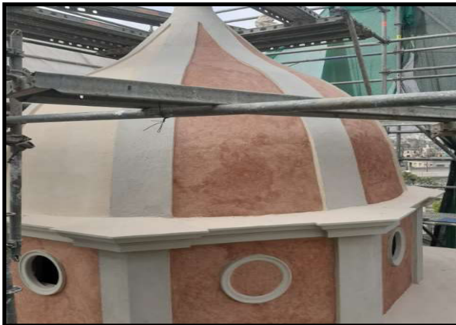
Fotografía N°53: Primera mano de pintura en cupulines de Sector 01
