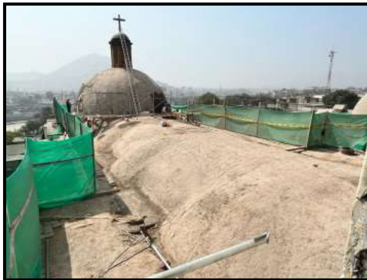
Fotografía N°17: Liberación de torta de barro en Sector 04
