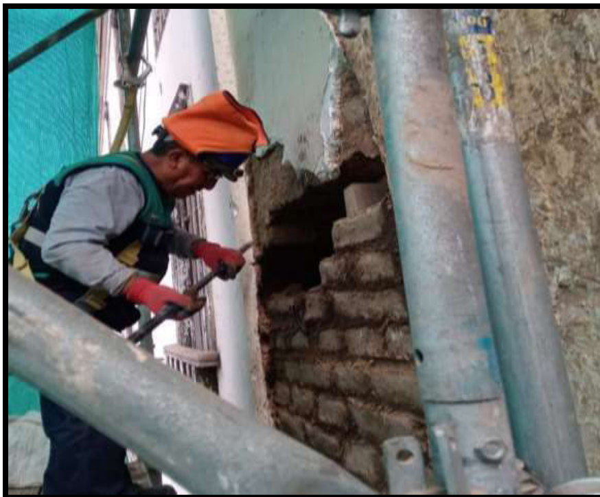
Fotografía N°65: Restitución de muros de adobe en Sector 03
