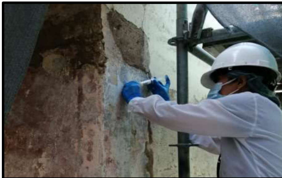
Fotografía N°13: Consolidación de pintura mural en Sector 01
