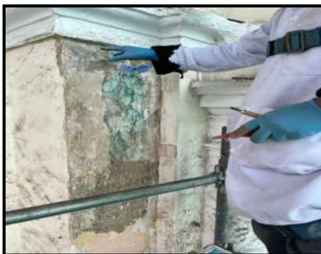
Fotografía N°20: Liberación de estratos superficiales en Sector 01
