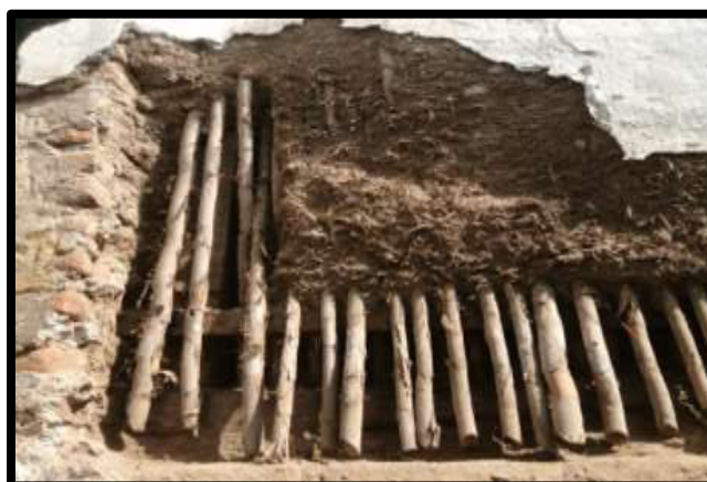
Fotografía N°10: Liberación de revoques de barro en telar de quincha en Sector 03
