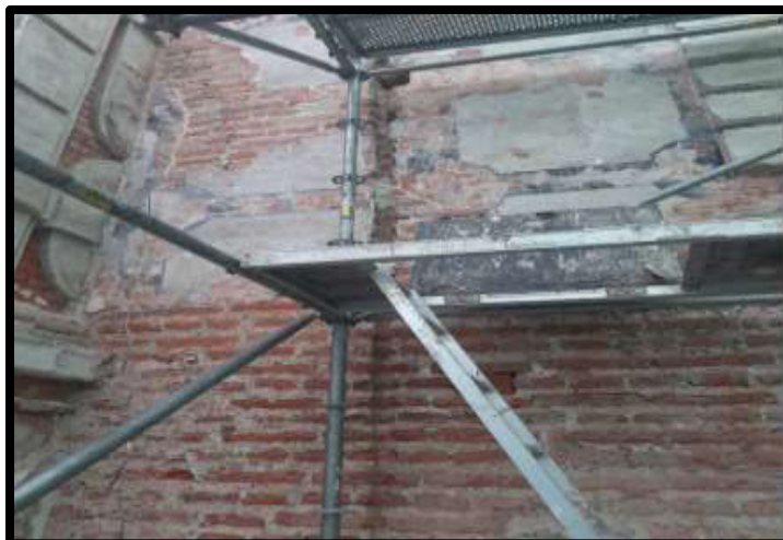
Fotografía N°05: Liberación de revoques incompatibles en Sector 01
