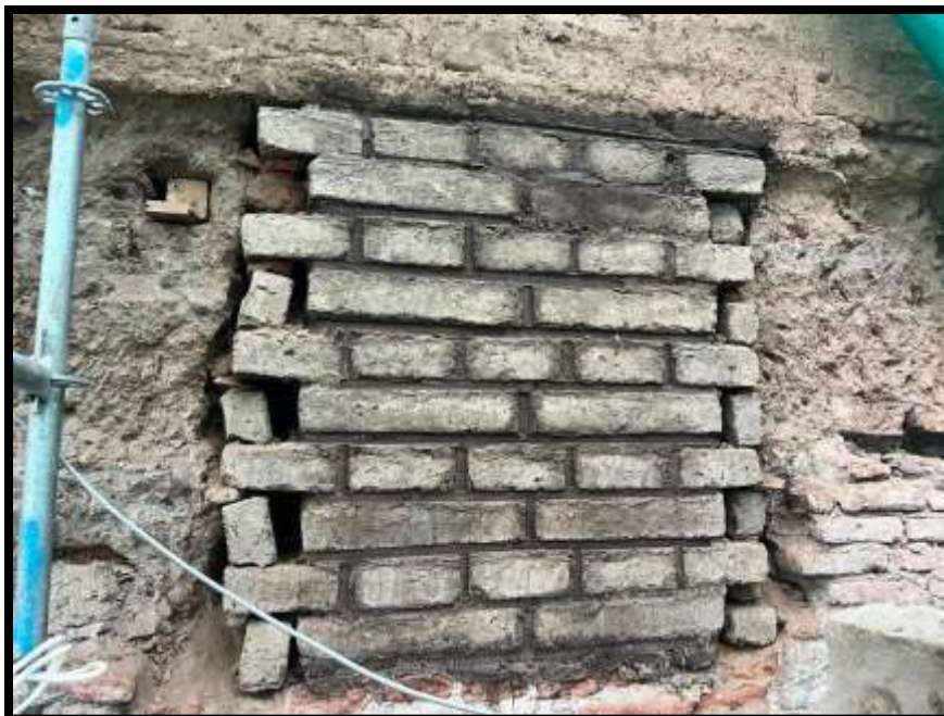
Fotografía N°29: Restitución de muro de adobe en Sector 02
