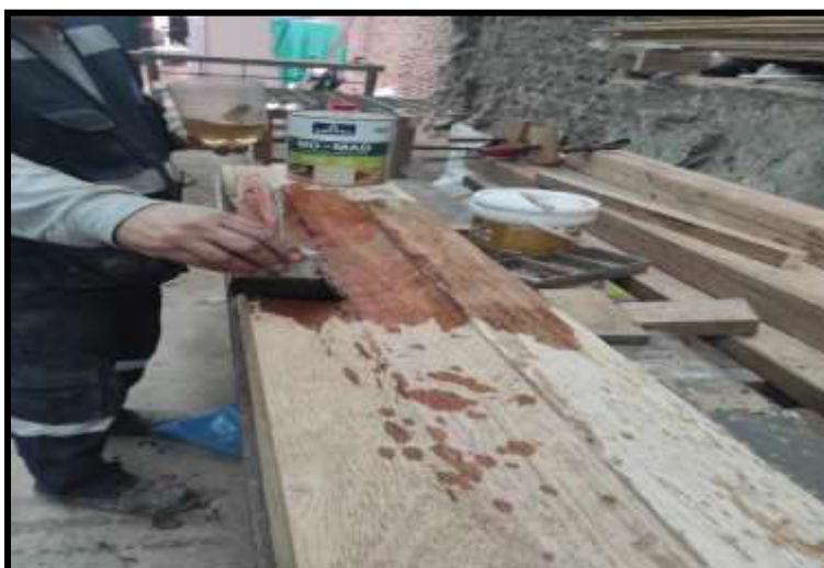
Fotografía N°22: Conservación elementos ornamentales de madera de Sector 02
