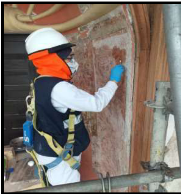
Fotografía N°25: Consolidación de pintura mural en Sector 01
