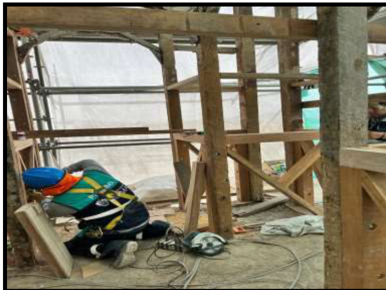
Fotografía N°37: Restitución de elementos estructurales de madera en Sector 01
