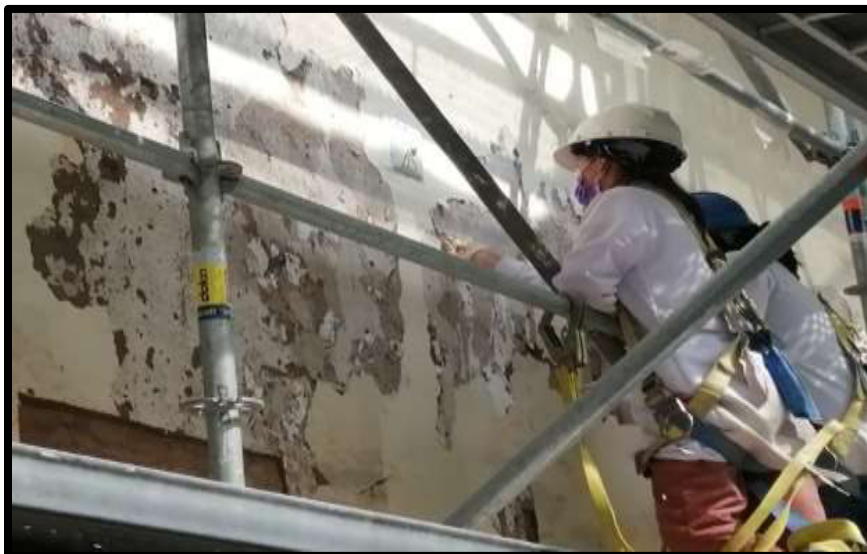
Fotografía N°09: Liberación de estratos superficiales en Sector 02
