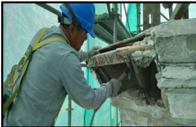
Fotografía N°28: Retiro de caña chancada incompatible en Sector 01
