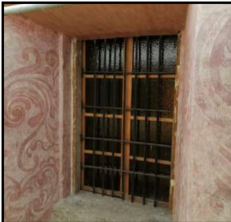
Fotografía N°61: Conservación de rejas metálicas en Sector 02
