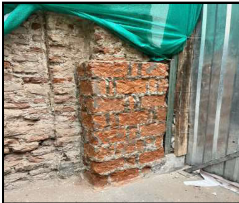
Fotografía N°23: Retiro de revoques incompatibles de cemento en Sector 02
