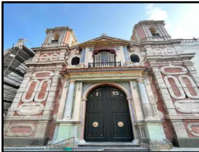
Fotografía N°57: Entrega de fachada de Sector 01
