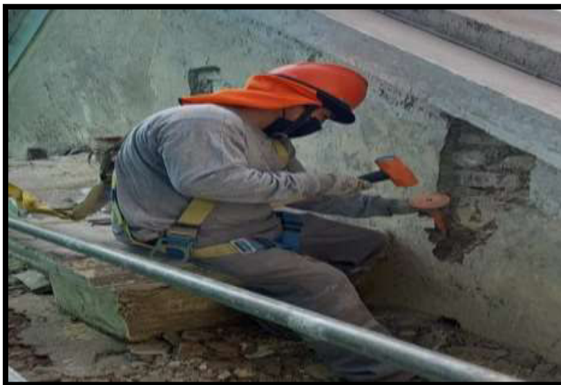
Fotografía N°40: Retiro de material incompatible en Sector 01
