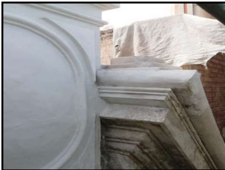
Fotografía N°54: Restitución de enlucido de cal en Sector 02
