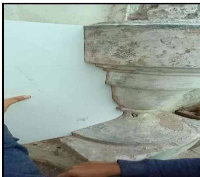
Fotografía N°16: Toma de medidas para conservación de ánforas de yeso en Sector 01
