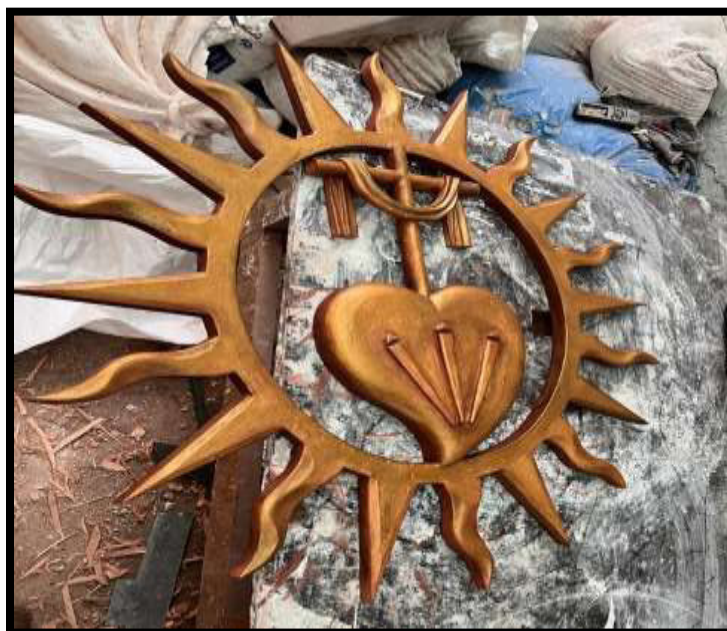
Fotografía N°58: Restitución de elementos ornamentales de madera en Sector 01
