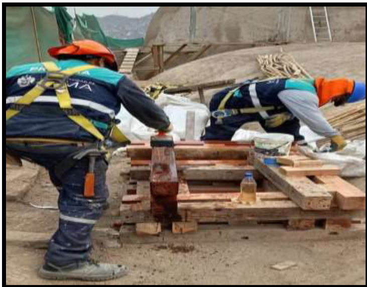
Fotografía N°39: Preservado de madera para restitución de elementos estructurales de madera en Sector 04
