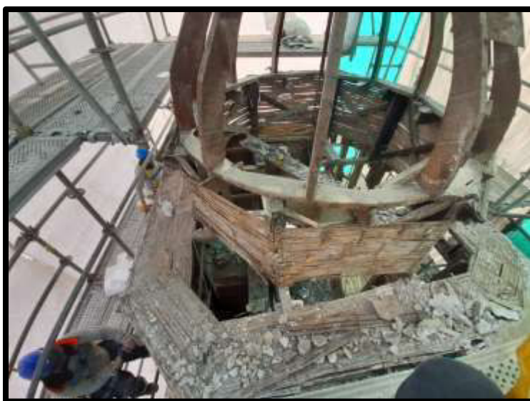
Fotografía N°08: Liberación de caña chancada incompatible en Sector 01
