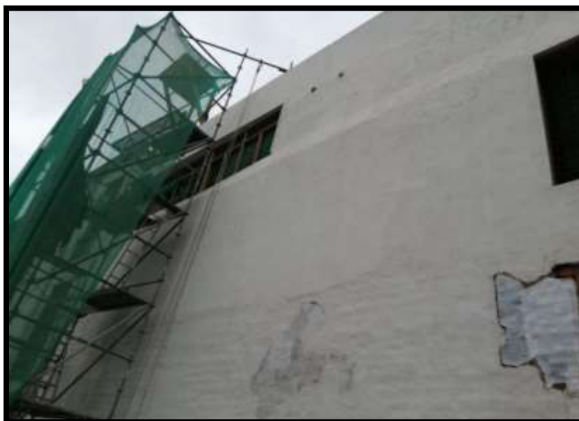
Fotografía N°56: Restitución de enlucido de cal en muros de Sector 03
