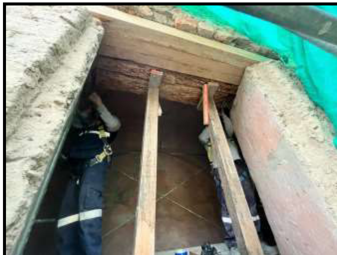
Fotografía N°21: Consolidación de elementos de madera en Sector 02
