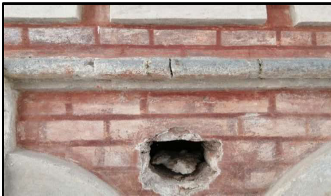
Fotografía N°14: Reintegración cromática en pintura mural de Sector 01
