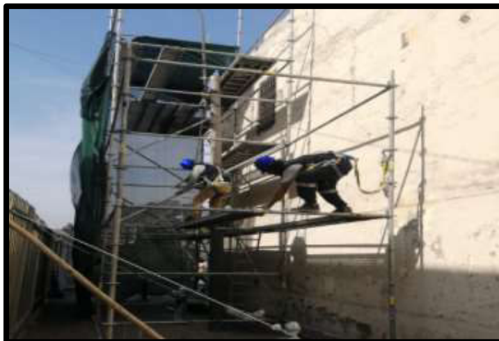
Fotografía N°01: Armado de andamios multidireccionales en Sector 02
