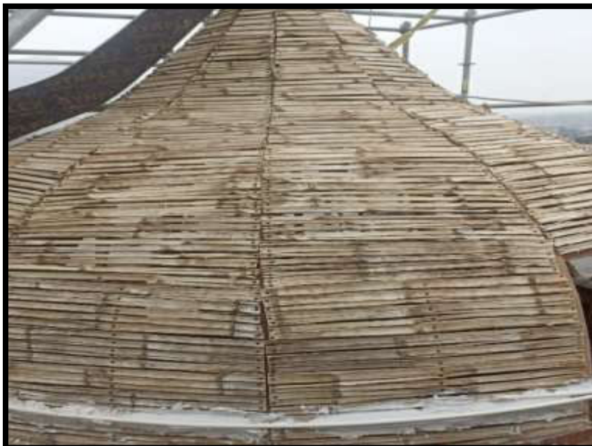
Fotografía N°49: Restitución de caña chancada en cupulines de Sector 01
