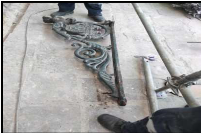
Fotografía N°15: Retiro de elementos incompatibles (brazos ornamentales) en la fachada de Sector 01
