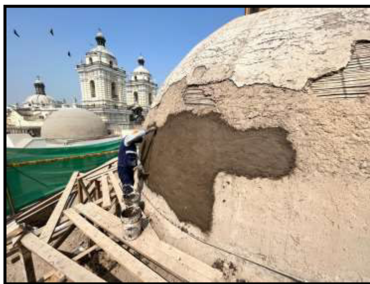
Fotografía N°18: Restitución de revoque de barro en Sector 04
