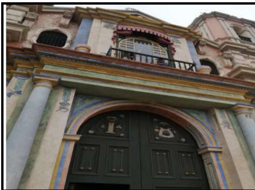
Fotografía N°44: Reintegración cromática de pintura mural en Sector 01
