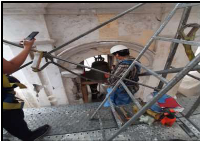
Fotografía N°03: Elaboración de calas exploratorias en Sector 01
