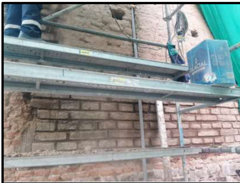
Fotografía N°68: Restitución de muro de adobe en Sector 02
