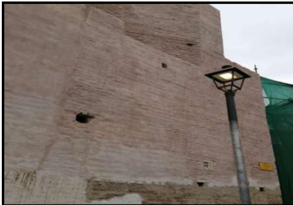
Fotografía N°47: Primera mano de pintura en muros de Sector 03
