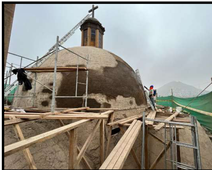
Fotografía N°31: Restitución de revoques de barro en Sector 04
