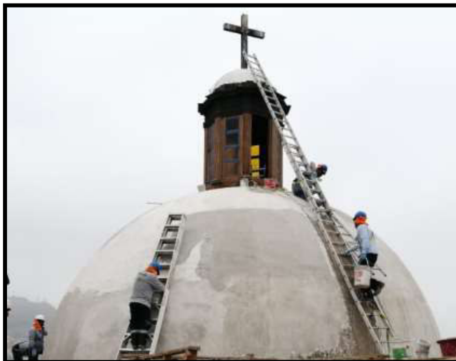
Fotografía N°46: Restitución de enlucido de cal en Sector 04
