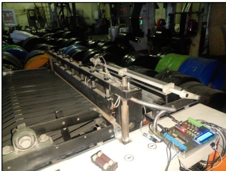
Figura 89. Montaje del NANO-PLC Fuente: Elaboración propia.
