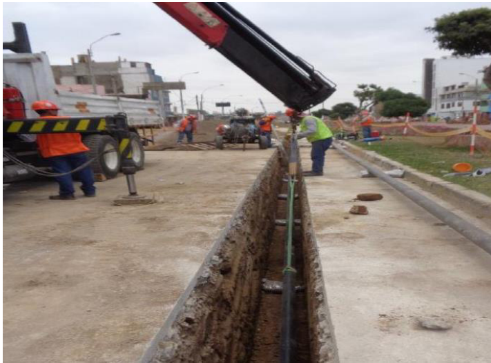
FIGURA N° 3.5: Instalación de tuberías
