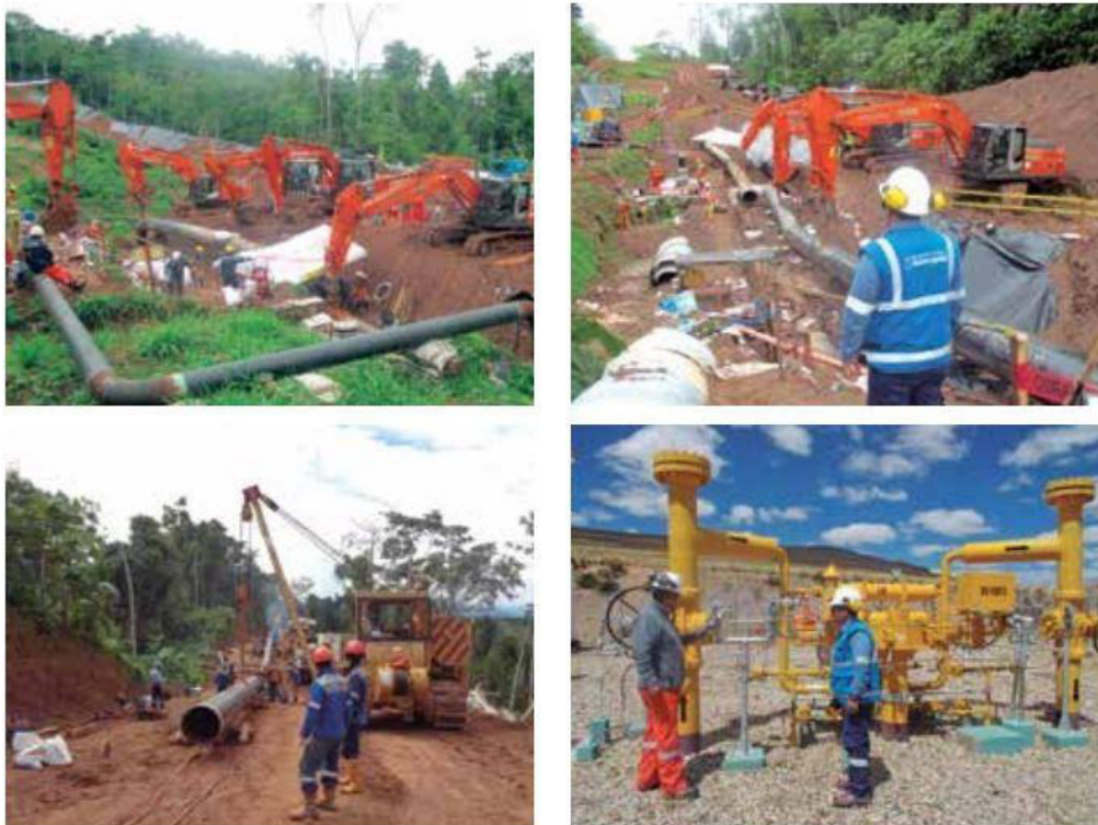
FIGURA N° 2.11: Construcción de los ductos para el transporte de gas natural y derivados. Fuente (Osinergmin ,2021)
