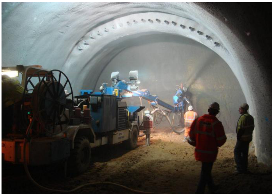
Figura 19. Imagen demostrativa del Concreto Lanzado.
