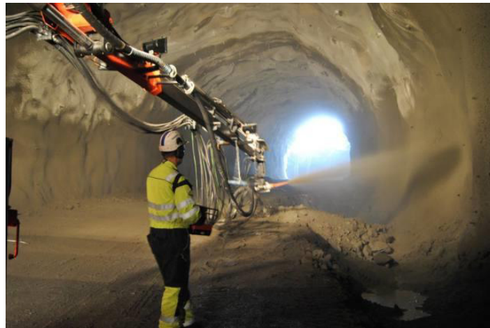
Figura 1. Concreto Lanzado.
