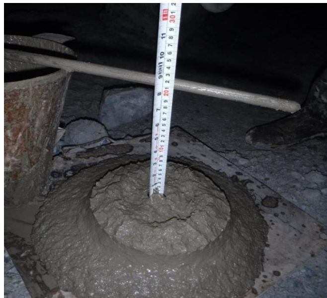
Figura 26. Medición del Slump para revisar la consistencia del concreto con relave desde su elaboración en planta hasta el punto de lanzado en la obra minera, y se mide con el cono de Abrams.
