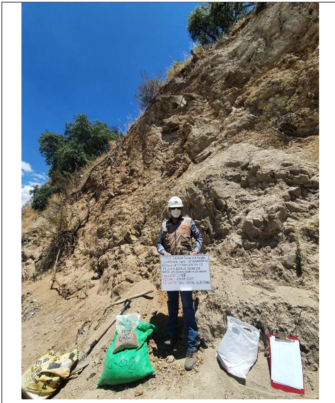
Figura 34. Exploración geotécnica in situ.
