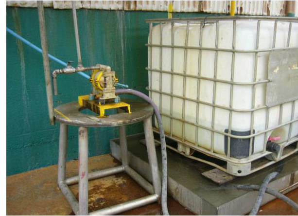
Sistema de alimentación de H_2O_2
