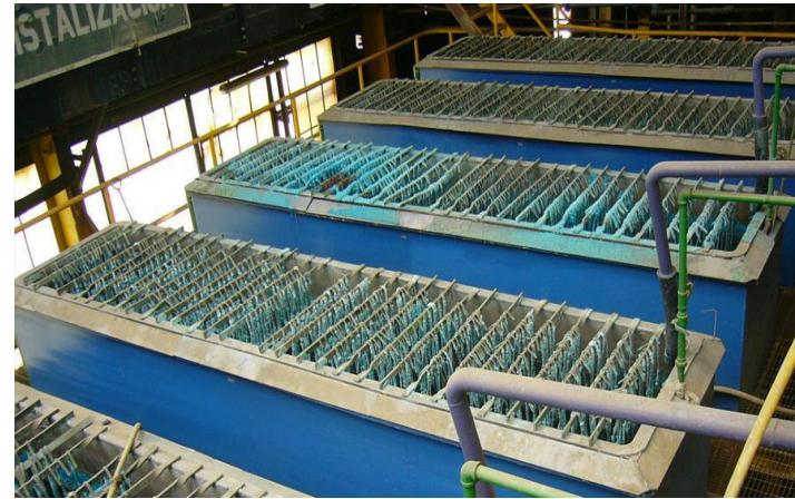
Celdas de producción de sulfato de cobre
