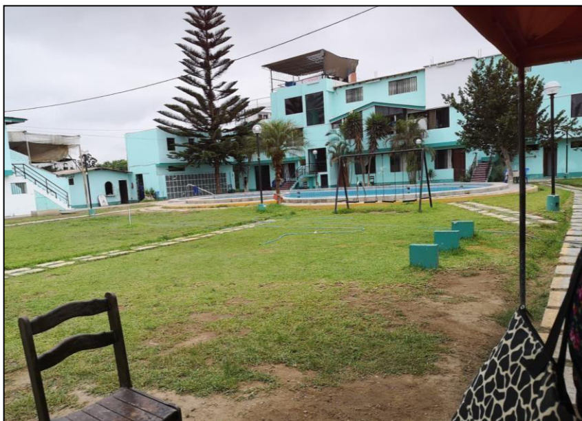
FOTO 1: Centro de Rehabilitación Sin Adicciones Perú
