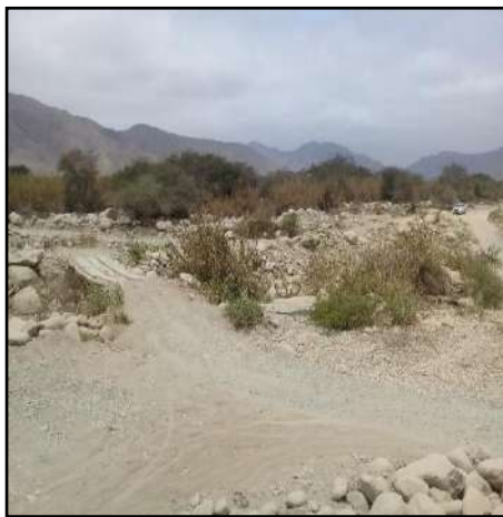
Figura N° 32: Vista del acceso del margen derecho al puente Huanchuy
