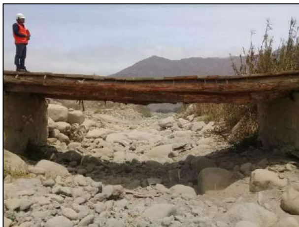
Figura N° 31: Vista del antiguo Puente Huanchuy hecho a base de troncos y estribos de concreto ciclópeo
