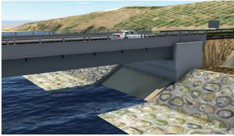
Figura N°03: Vista del perfil longitudinal del Enrocado N°02 del plano Enrocado Puente Huanchuy – Planta Perfil
