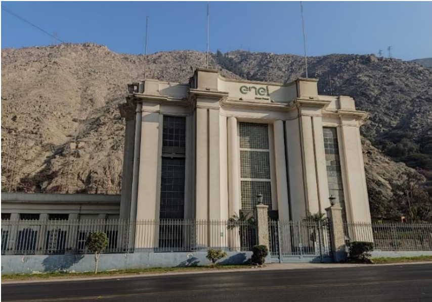
Central Hidroeléctrica de Moyopampa
