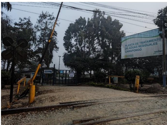
Planta de Tratamiento de Aguas Residuales Carapongo
