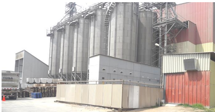
Figura 17. Vista exterior de la subestación y planta Rinti S.A. Fuente propia
