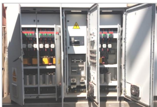
Figura 27. Banco de condensadores con reactancias antiresonantes implementado Fuente propia
