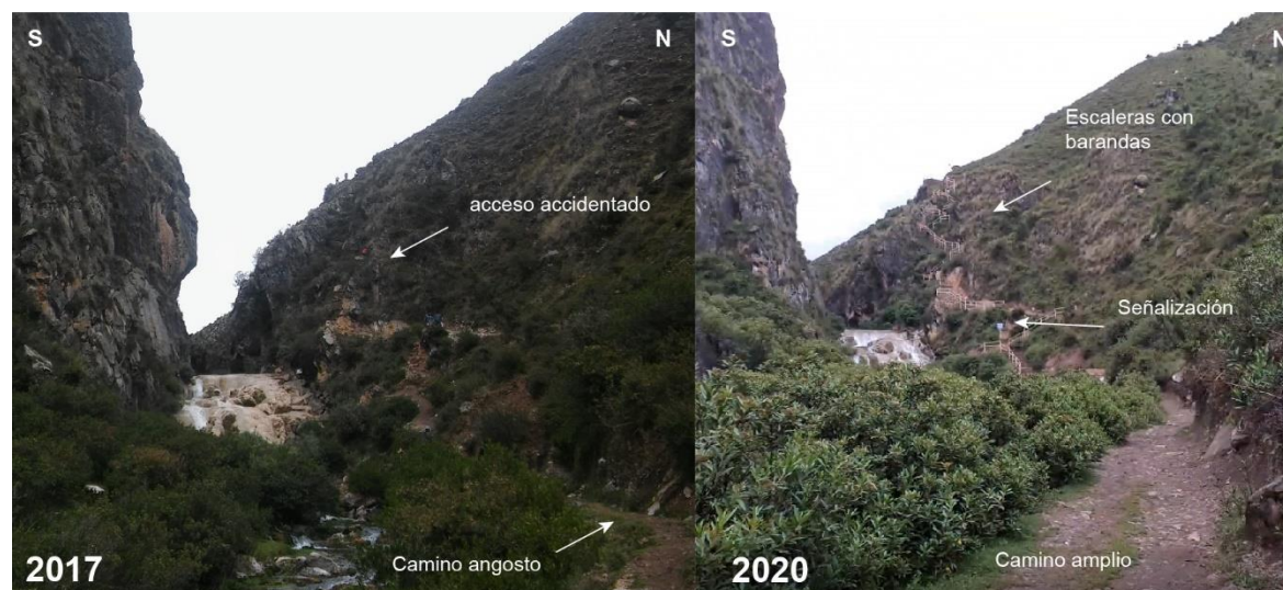
Figura 27 Condiciones del acceso en 2017 y 2020
