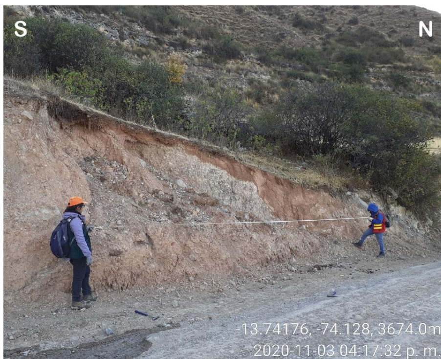
Figura 63 GD24 Caída de tierra
