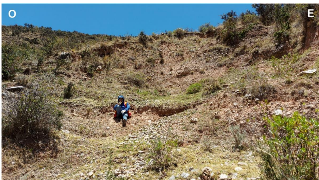
Figura 65 GD12 Deslizamiento rotacional
