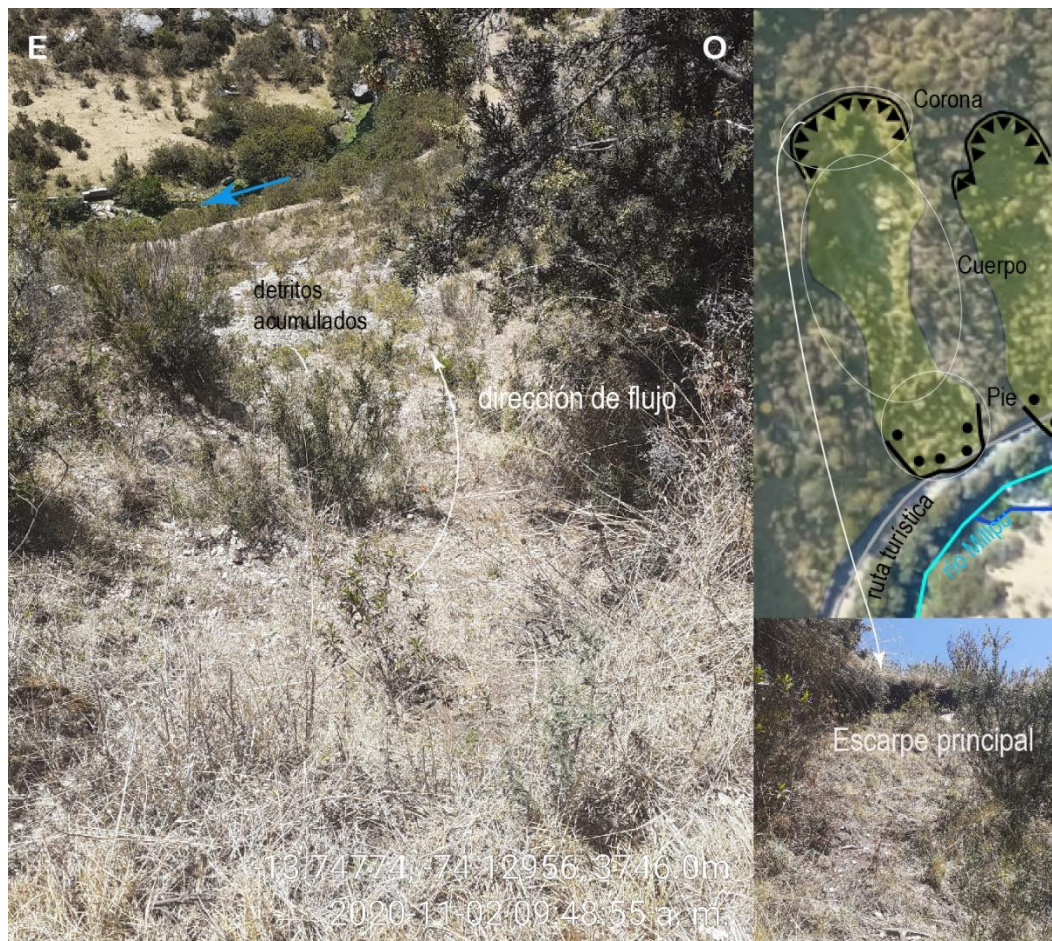
Figura 55 GD07 flujo de detritos
