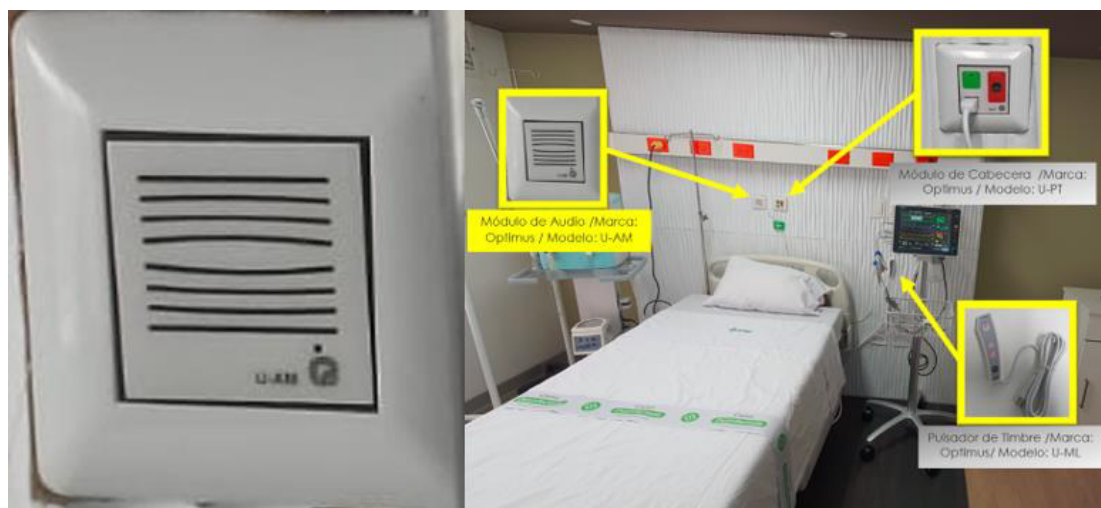
Figura 16: Módulo de Audio Optimus / Modelo: U-AM. Fuente: Actividad laboral.
