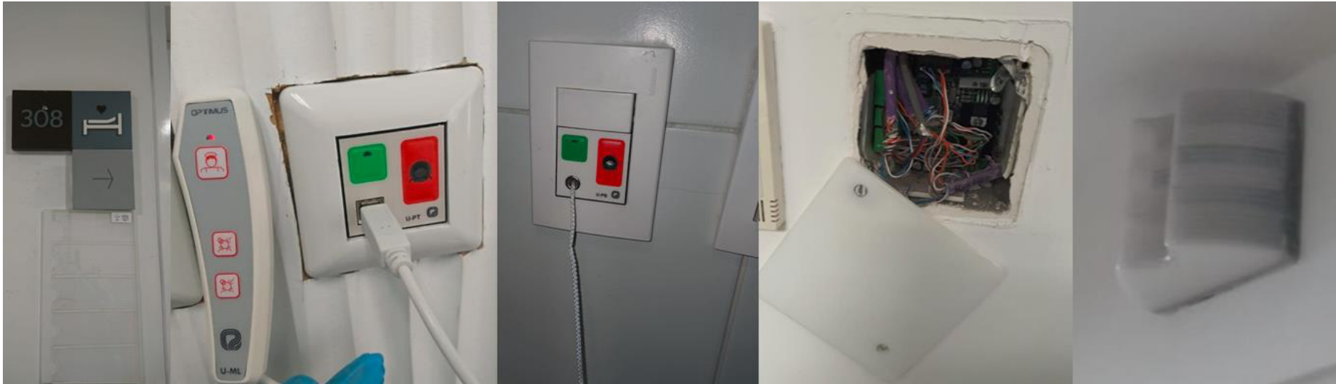
Figura 58: Componentes del sistema de llamado de enfermeras Optimus – Habitación 308. Fuente: Actividad laboral.
