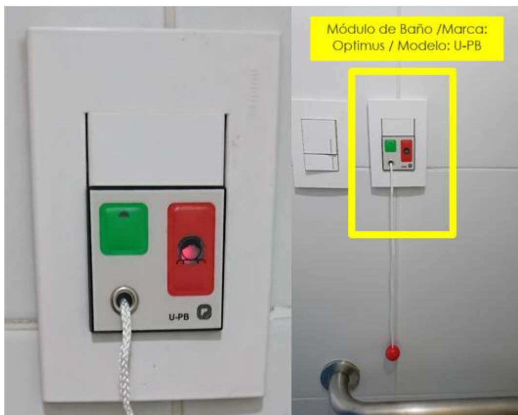
Figura 14: Módulo de Baño Optimus / Modelo: U-PB. Fuente: Actividad laboral.
