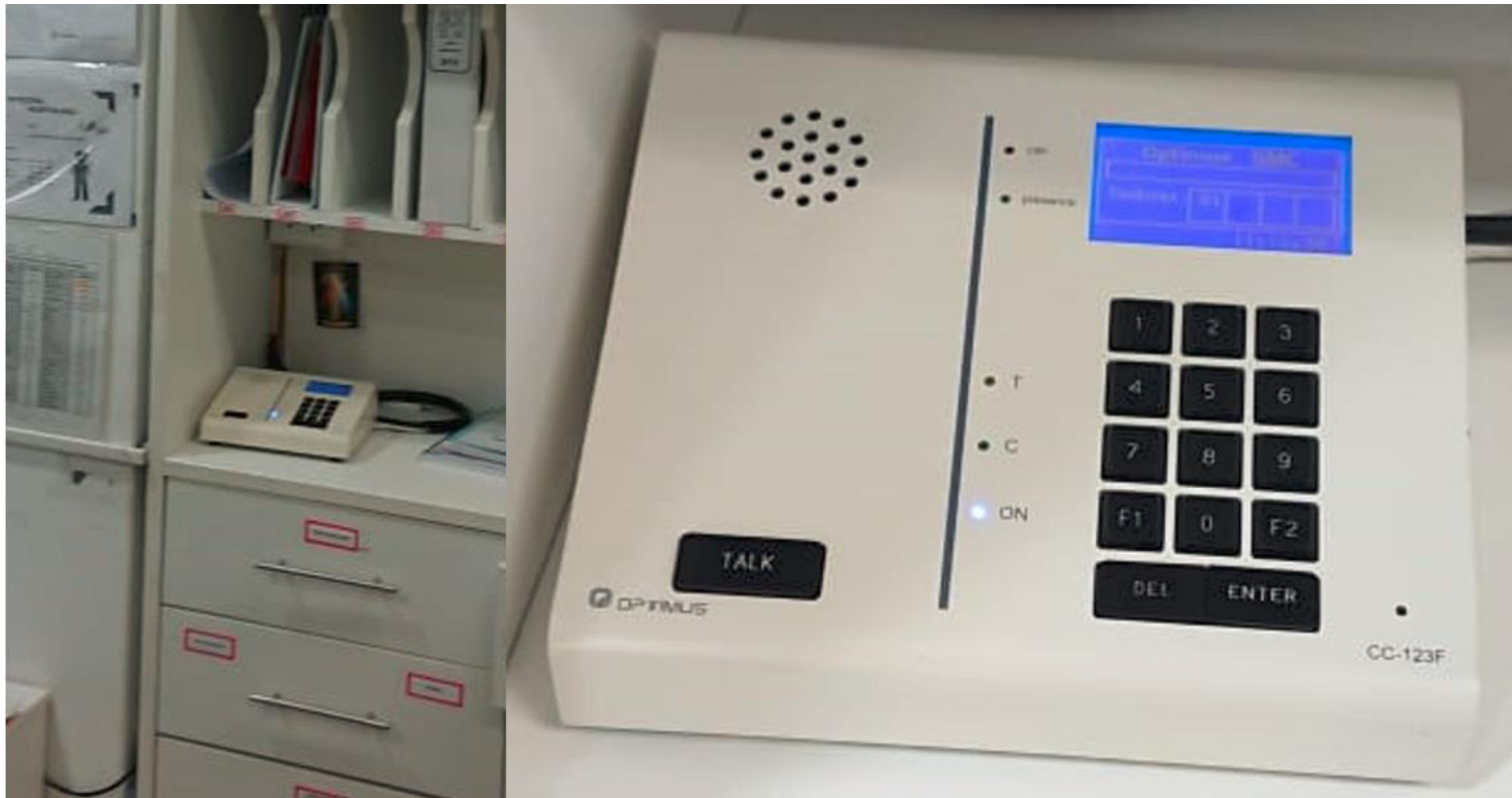
Figura 69: Central de control de llamadas Optimus – Hospitalización no COVID-19. Fuente: Actividad laboral.
