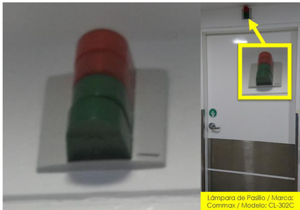
Figura 34: Lámpara de Pasillo Commax / Modelo: CL-302C. Fuente: Actividad laboral.
