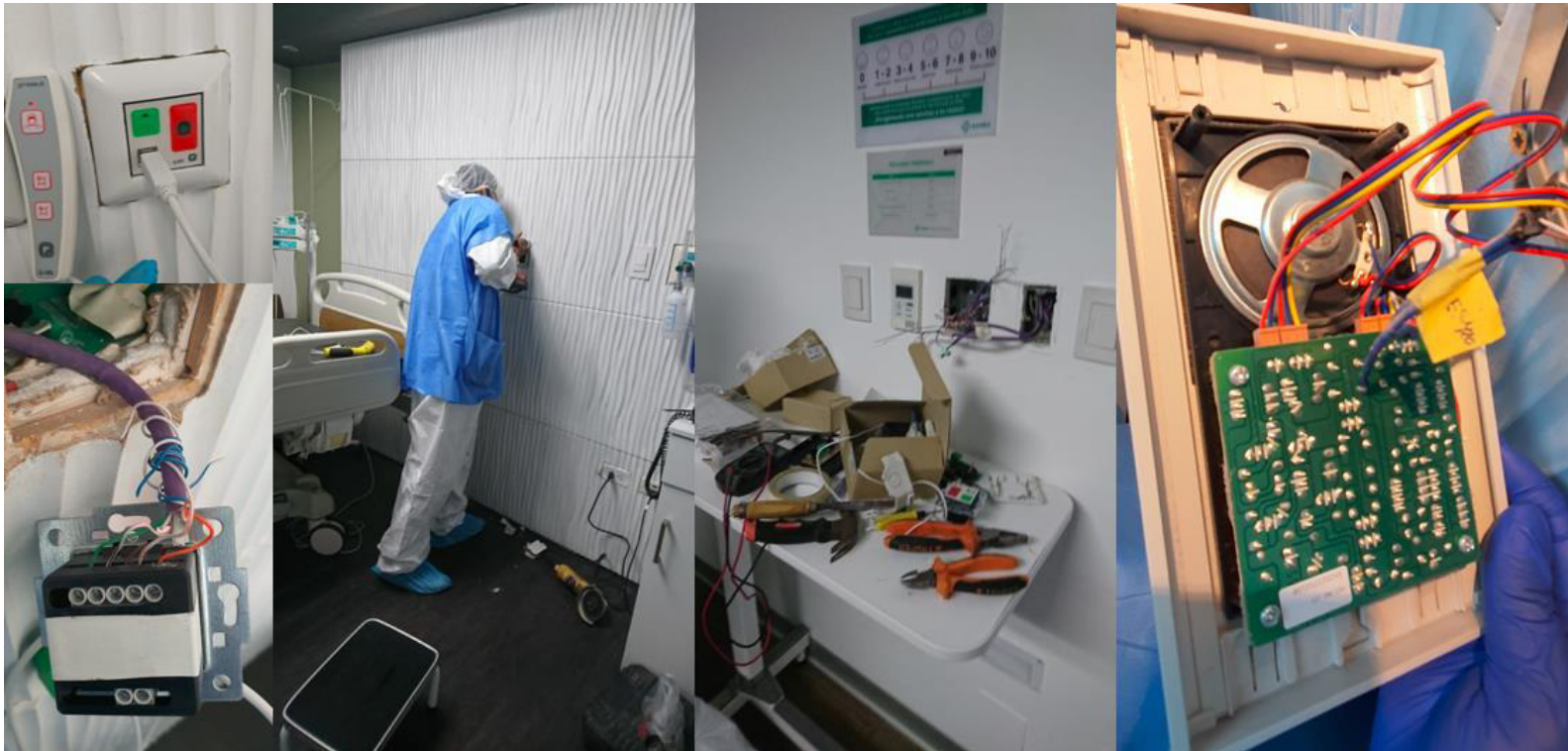
Figura 59: Adaptación de zócalos e instalación – Habitación 308. Fuente: Actividad laboral.
