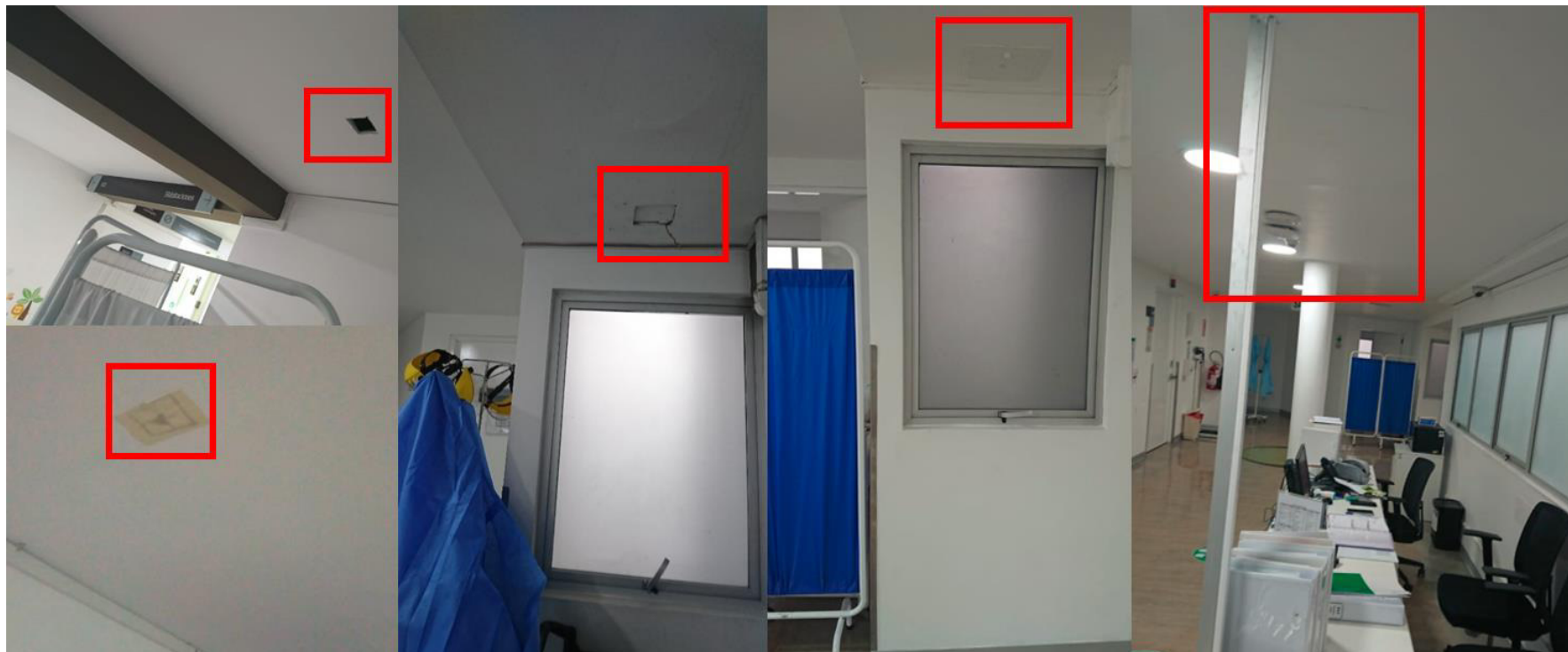
Figura 61: Resane en aberturas realizadas – Habitación 308. Fuente: Actividad laboral.
