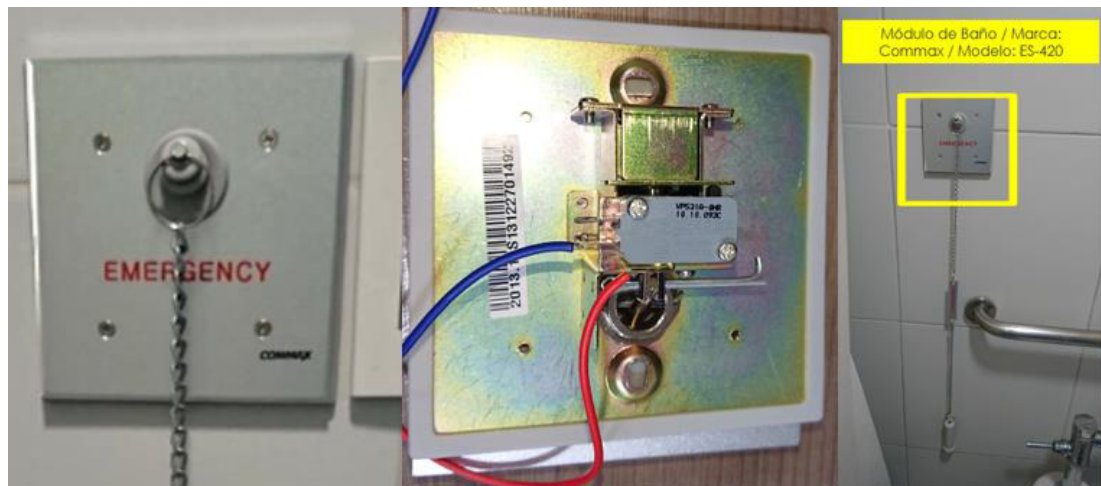
Figura 32: Módulo de Baño Commmax / Modelo: ES-420. Fuente: Actividad laboral.
