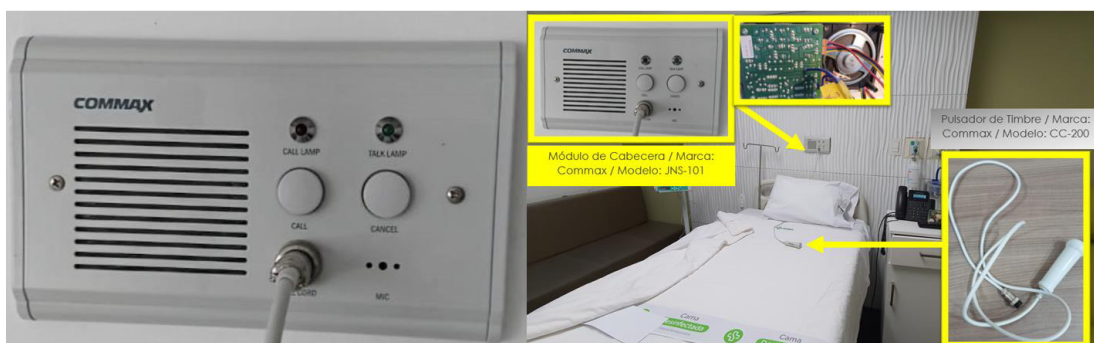
Figura 30: Módulo de Cabecera Commax / Modelo: JNS-101. Fuente: Actividad laboral.
