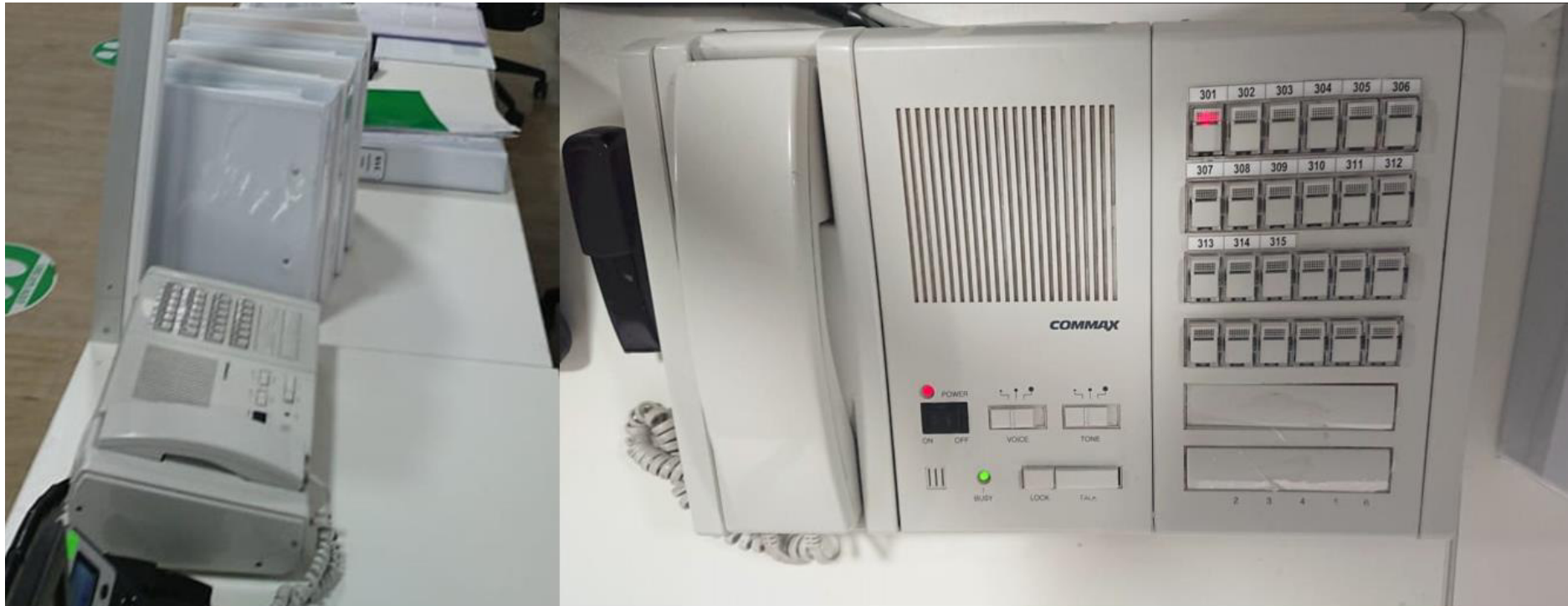
Figura 68: Central de control de llamadas Commax – Hospitalización COVID-19. Fuente: Actividad laboral.
