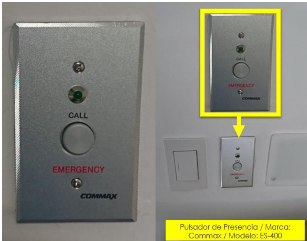
Figura 33: Pulsador de Presencia Commax / Modelo: ES-400. Fuente: Actividad laboral.
