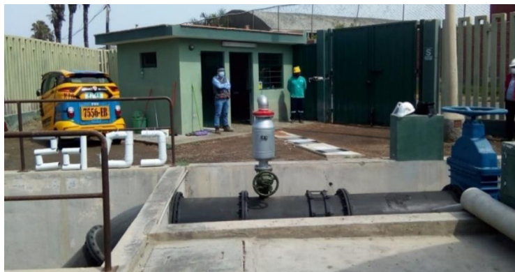
Caseta de Seguridad de la CD-65
