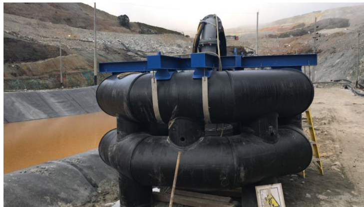
Figura 30: Bomba en barcaza antes de entrar en operación.
