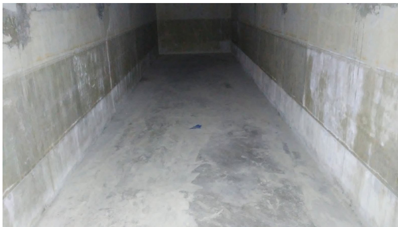
Figura 5. Cisterna de agua contra incendio, en proceso de construcción.
