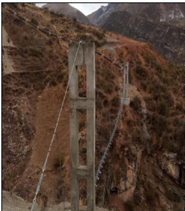
Foto N°08: Se muestra panorámica del Pase Aéreo construido.
