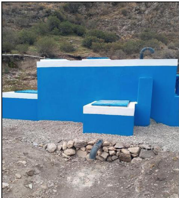
Foto N°01: Se muestra la Cámara de Reunión de Caudales construida.
