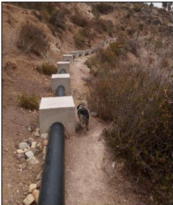
Foto N°09: Se muestra la vista de los Dados de Anclaje construidos.
