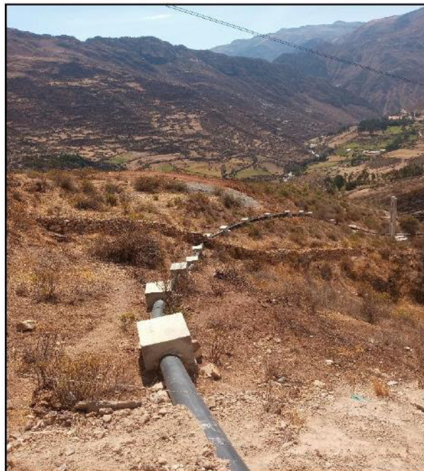
Foto N°02: Se muestra la construcción de la Línea de Conducción.
