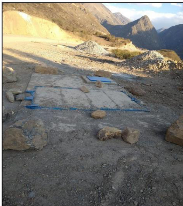
Foto N°03: Se muestra la vista externa de la cámara que contiene la válvula reductora de presión.
