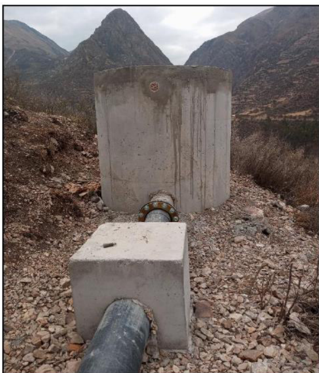
Foto N°07: Se muestra la vista panorámica de la Cámara de la Válvula de aire construida.
